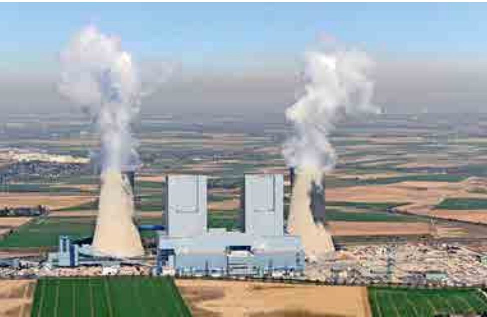
Moderne Kohlekraftwerke. Sie können Leistung kurzfristig um 500 Megawatt variieren.
