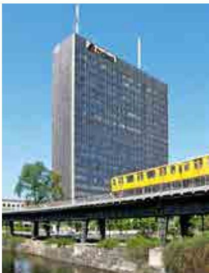
Im 89 Meter hohen Postscheckamt in Berlin sollen 330 Wohnungen entstehen.
