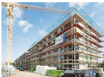
Neubau in der Landsberger Straße
