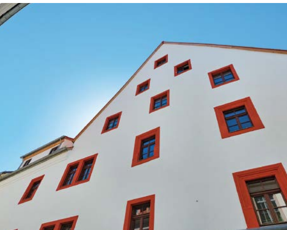
Die roten Fensterfaschen an der Fassade nach historischem Vorbild sind von Weitem zu erkennen
