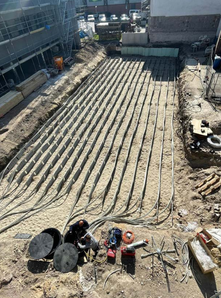
Besonders bei der Dekarbonisierung ganzer Quartiere sind kalte Nahwärmenetze eine gute Lösung. Hier besteht die Möglichkeit, mehrere Wärmequellen parallel oder in Ergänzung zueinander einzusetzen
