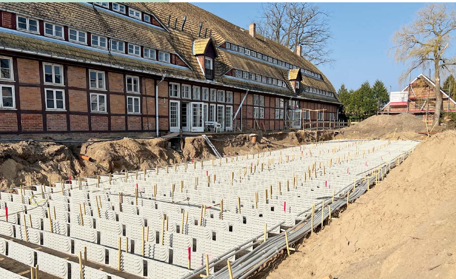
Beim Ausbau der Klosteramtsscheune in Dobbertin zu einer integrativen Wohnanlage wurde nach den Plänen des Chemnitzer Unternehmens Geocollect eine Erdkollektoranlage mit 150 kW Heizlast installiert
