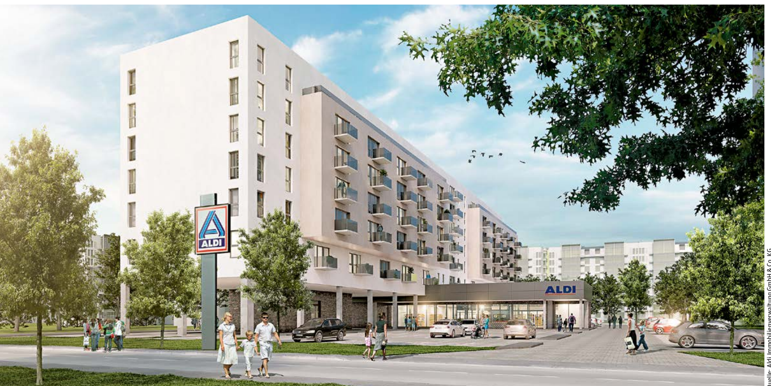
In Berlin-Lichtenberg will Aldi Nord zeigen, wie eine gemischt genutzte Immobilie mit Discounter und Wohnungen aussehen kann. Noch haben die Bauarbeiten aber nicht begonnen
