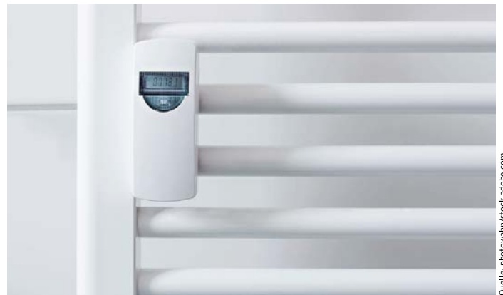
Elektronische Heizkostenverteiler, die nach dem 25. Oktober 2020 installiert werden, müssen laut EED fernablesbar sein
