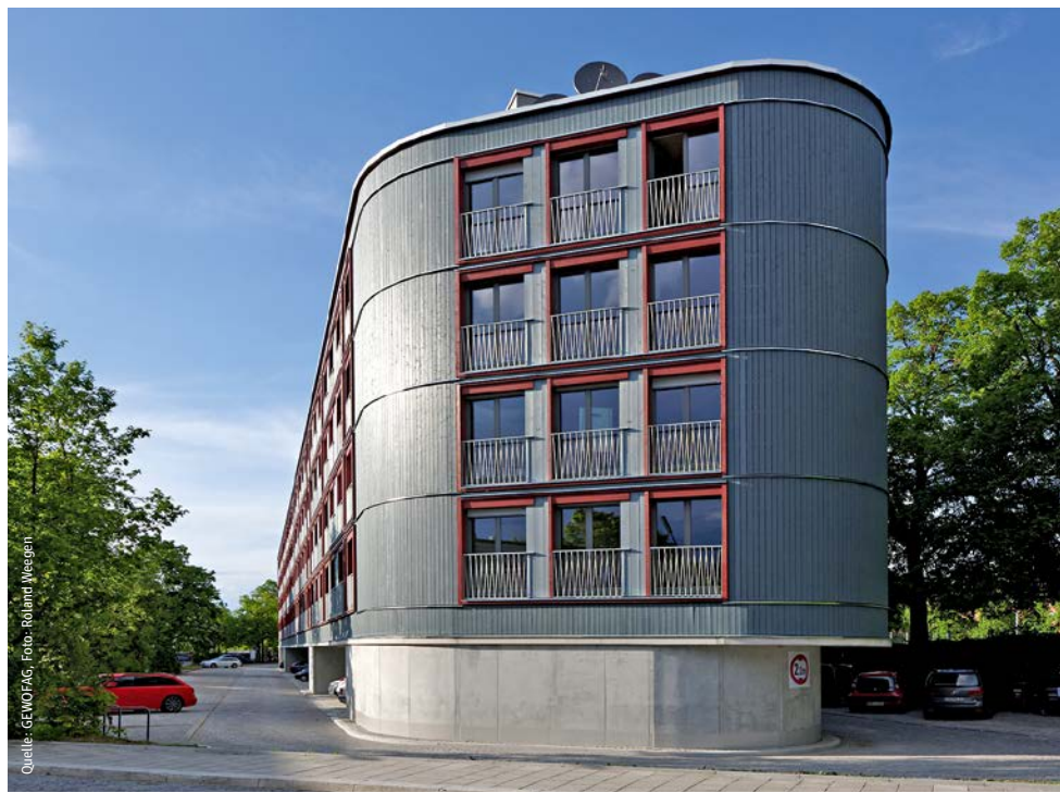
Ein bundesweit beachtetes Pilotprojekt: In München hat die GEWOFAG einen Parkplatz mit 100 Wohnungen überbaut (siehe auch DW 10/2017, S. 34)
