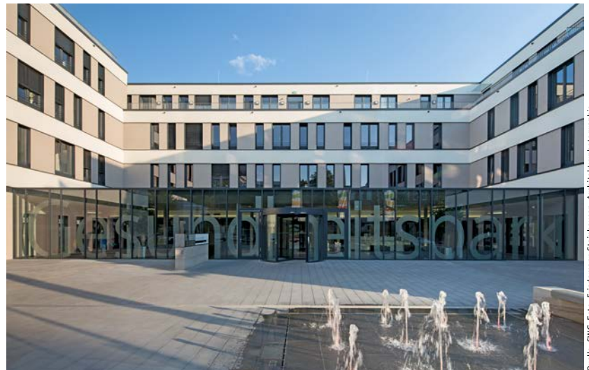
Quelle: SWG, Foto: Friedemann Steinhausen, Architekturphotographie
