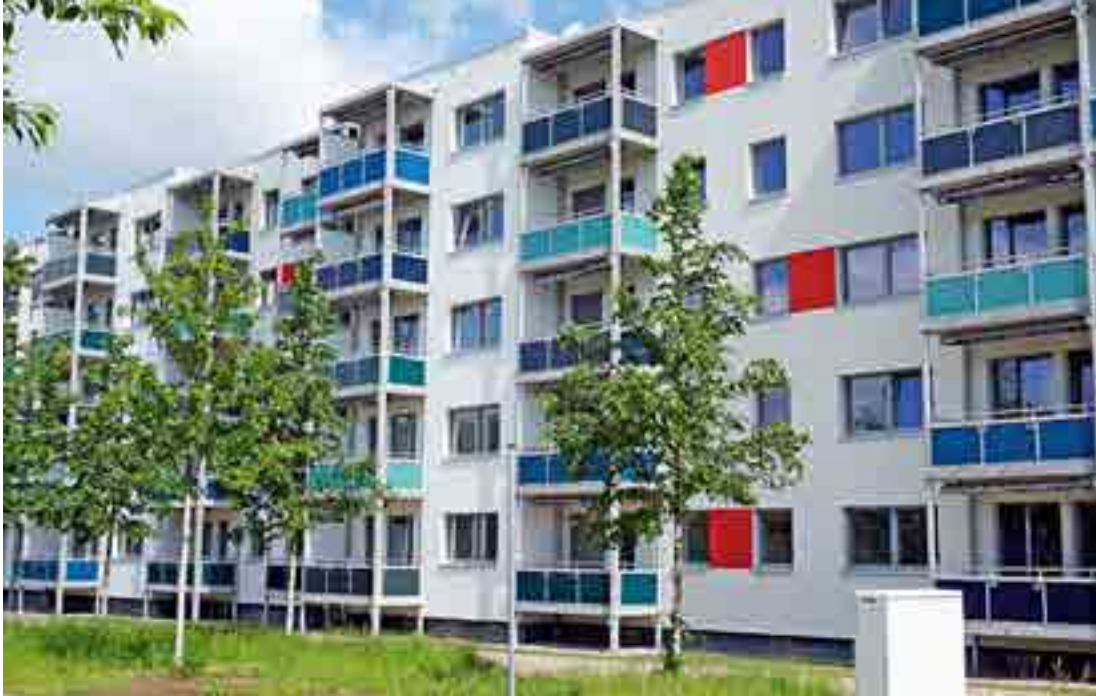
13 Monate lang wurde der 5-Geschosser in der Neubrandenburger Straße in Schwerin intensiv saniert und modernisiert. Das aus dem Jahr 1977 stammende Gebäude ist heute kaum wiederzuerkennen
