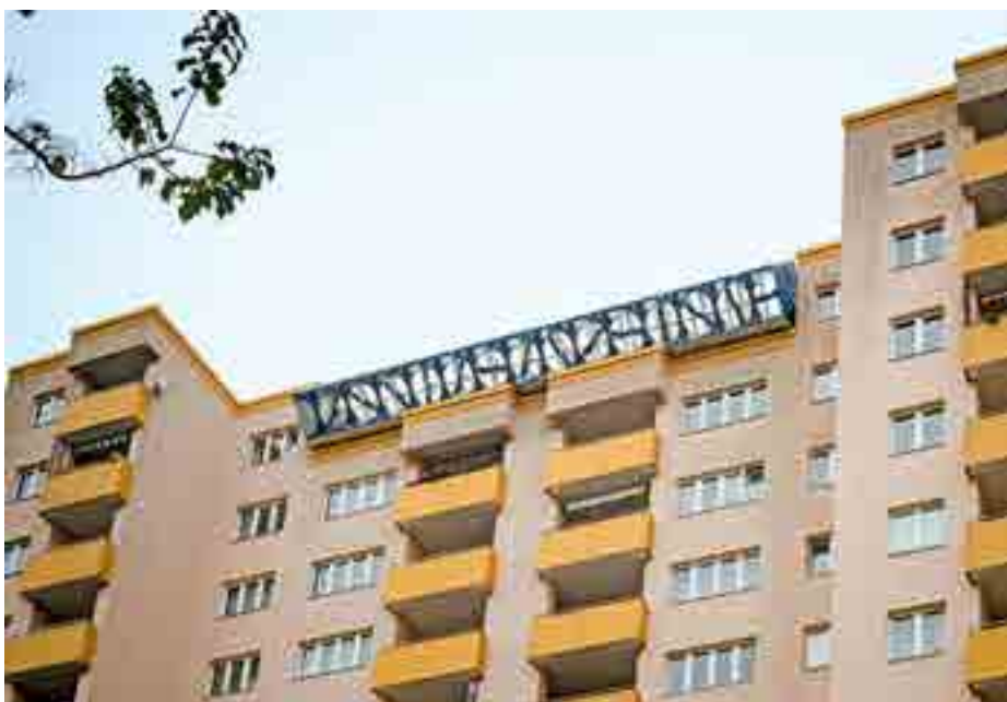
Das Windrail-System ist an der Dachkante installiert und bildet so einen Teil des Gebäudes
