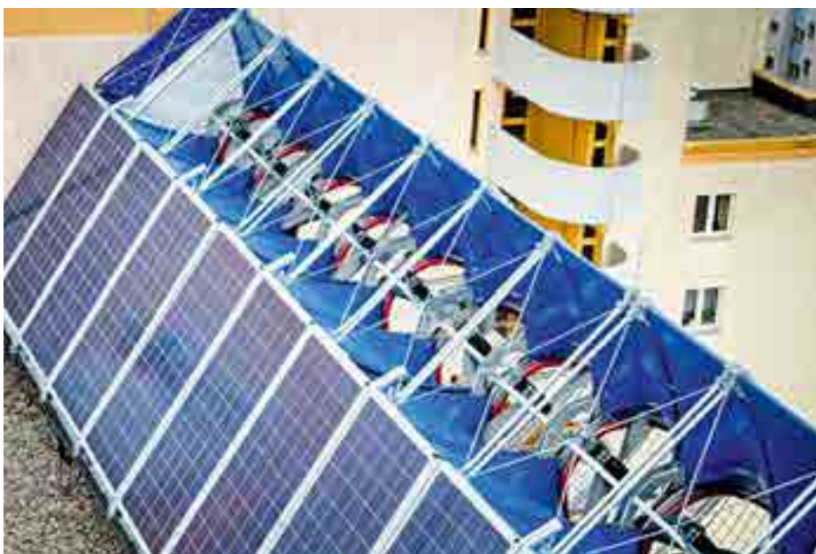
Ein Blick ins Innere des von der Anergdy AG entwickelten Windrail-Moduls, das auf den Dächern von zwei Wohnanlagen der Berliner Gewobag installiert ist
