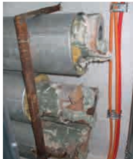
Leitungs-dämmungen aus Mineralwolle
