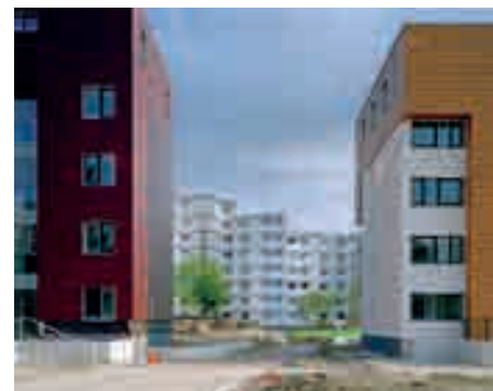
Der Rückbau reduziert die Wohnflächen in der Neuen Burg enorm.
