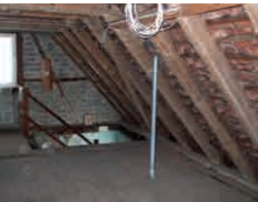
Dachstuhl mit Holzschutzmitteln behandelt
