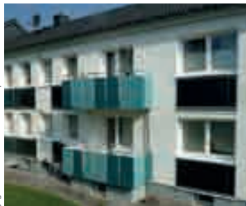
Das Gebäude nach der Sanierung.
