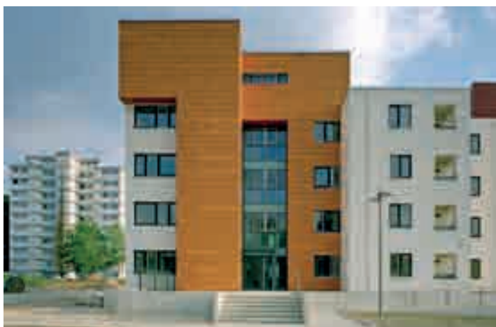
Holzoptik wechselt ab mit Putzfassaden.
