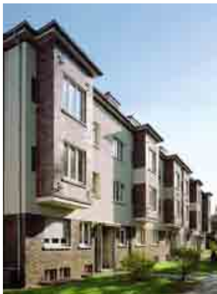
Holzfenster im Austausch zu den Sanierungsfenstern der 1980er Jahre.
