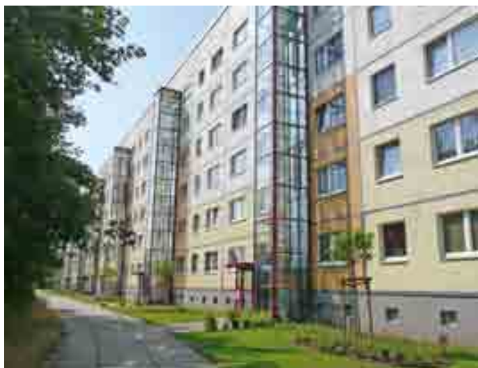
Bereits in den Vorjahren wurden an den Objekten der WG Lipsia in der Uranusstraße Aufzüge angebaut.
