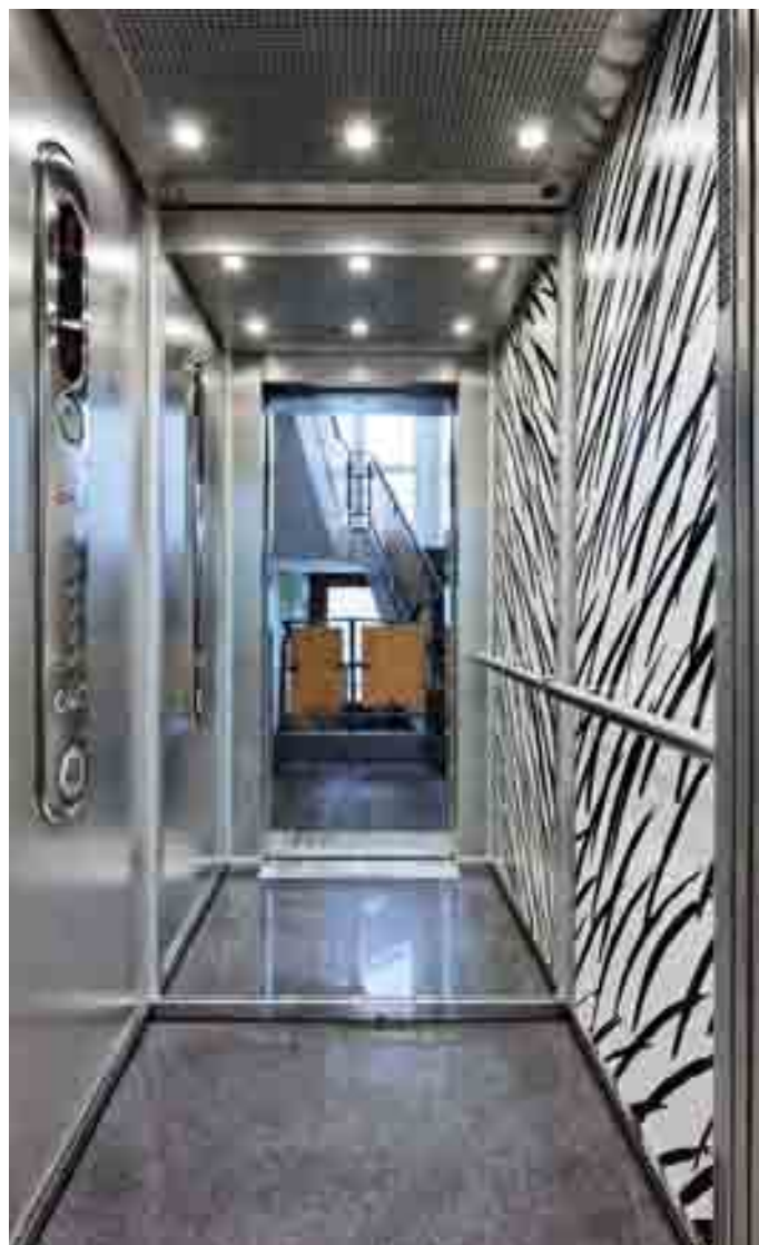
Die Dekorfolie im Aufzug kann einfach ausgetauscht werden. Quelle: Kone
