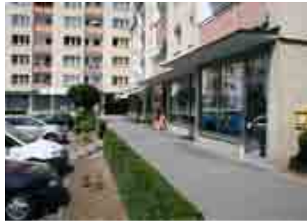
Die Woge Werdohl revitalisierte die Ladenzeile im Stadtteil Ütterlingsen. Unter den neuen Mietern sind allerdings vor allem Dienstleister – ein Nahversorger hätte an diesem Standort keine Chance.
