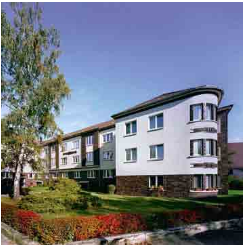
Positives Beispiel für Investitionen in den Denkmalschutz: das Wohnensemble in der Oldenburgallee.
