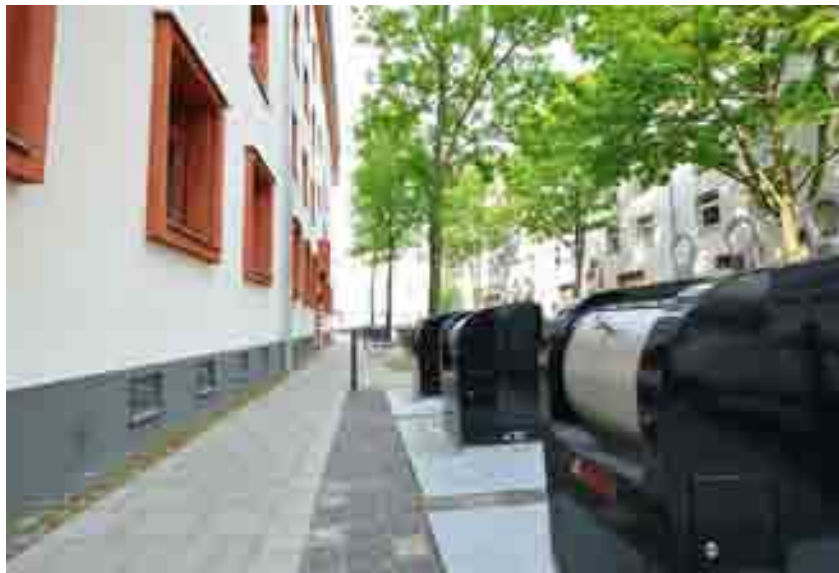
Sanierte Naumannsiedlung: Unterflur-Müllsystem
