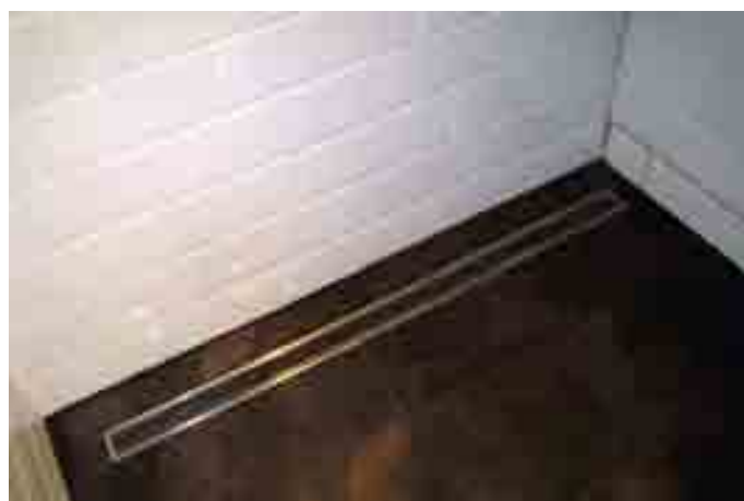
In diesem denkmalgeschützten Haus im ostwestfälischen Rheda-Wiedenbrück wurde das Badezimmer mit einer bodengleichen Dusche mit Linienentwässerung modernisiert.
