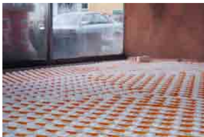
Mit dem Keramik-Klimaboden BEKOTEC-THERM lässt sich nicht nur energiesparend heizen – dank seiner niedrigen Aufbauhöhe bleibt auch Raum für zusätzliche Trittschalldämmung.
