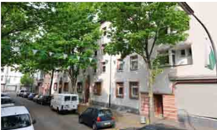
Naumannsiedlung: noch nicht sanierter Straßenzug heute
