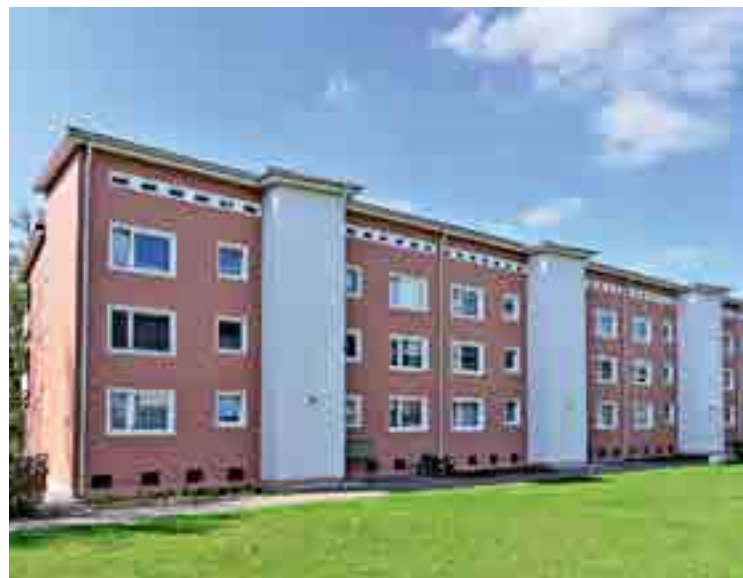
Basismodernisierung in der Ossietzkystraße
