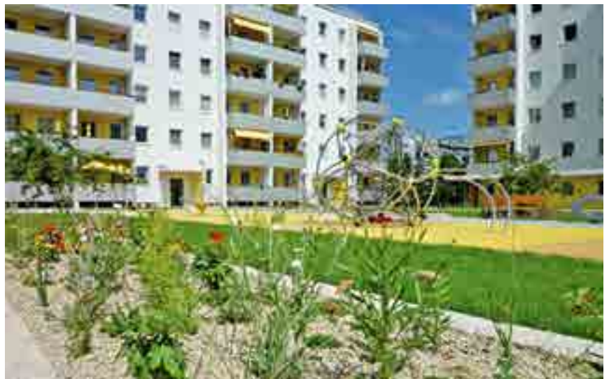
Viel Wert legte die SWG auf die Gestaltung der Außenanlagen
