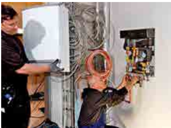
Montage einer Frischwasserstation
