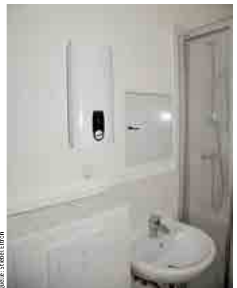
Beanspruchen wenig Platz: Durchlauferhitzer in einer der modernisierten Wohnungen in Wolfen
