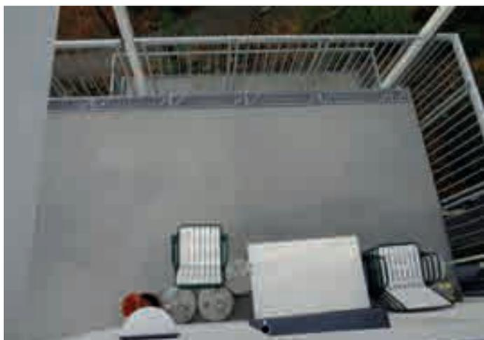
Eine verschleißfeste Abdichtung und einen langzeitigen Schutz vor eindringender Feuchtigkeit auch für punktuell beanspruchte Böden auf Balkonen bietet das Triflex System BTS-P. Türanschlüsse, Leisten, Rinnen und Maueraufzüge können in die Abdichtungsfläche integriert werden, um ein Hinterlaufen von Wasser zu vermeiden.
