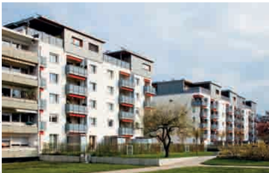
Nachverdichtung durch neue Penthousewohnungen und Aufstockungen durch hochwertige Attikawohnungen in der Teichmattensiedlung in Lörrach.
