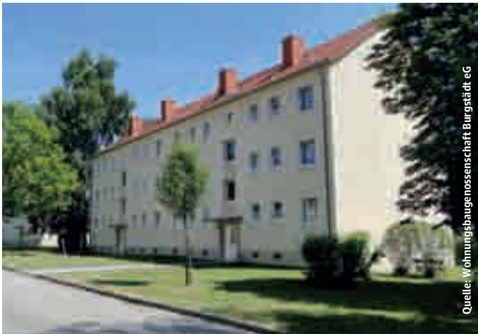
In der unteren Etage errichtete die WG Burgstädt eG die erste Modellwohnung im Rahmen des Projektes „AlterLeben“.
