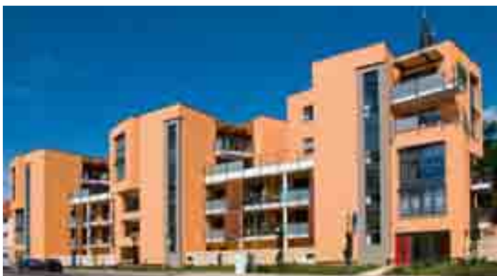
„DomiZiel – Das Mehrgenerationenhaus“: KfW-40-Standard, 20 Wohnungen mit kontrollierter Wohnraumlüftung, 60-kW-Wärmepumpen, Erdwärme. Quelle: WGH eG
