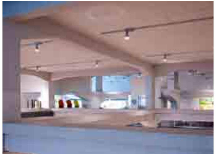
Beim Umbau der beiden unteren Stockwerke wurde die Stahlbetontragstruktur des ehemaligen Parkhauses erhalten.
