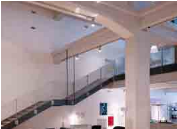
Beim Umbau der beiden unteren Stockwerke wurde die Stahlbetontragstruktur des ehemaligen Parkhauses erhalten.
