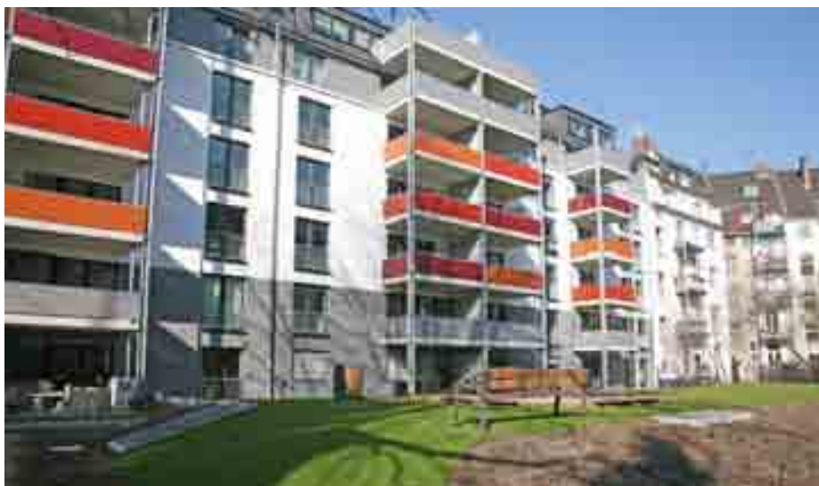
Hofansicht des neugebauten Mehrfamilienhauses der WG Köln 1896, in Köln-Deutz, Hasertstraße 5-9.
