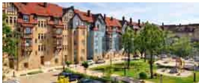
Innenhof der historischen Wohnanlage Vatikan in Bad Cannstatt.
