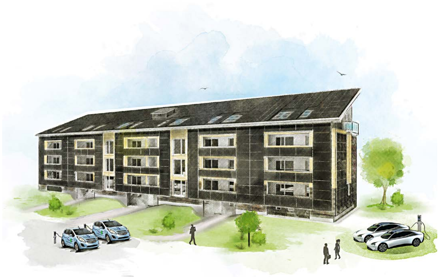
Vom energiefressenden Plattenbau zum teilautarken Gebäude: Bis auf die Nordfassade ist die komplette Gebäudehülle mit PV-Modulen verkleidet. Das neu aufgesetzte Pultdach bietet zusätzliche Wohnfläche und eine optimale Ausrichtung der PV-Anlage
