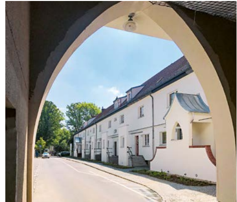
Reihenhäuser in der Reglinstraße nach der Sanierung. Wiederhergestellt wurden auch einzelne der pagodenartigen Vorbauten
