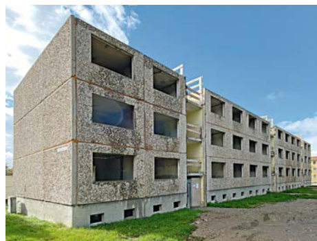
Gute Substanz vor dem Sanierungsstart: Die oberen beiden Etagen wurden abgetragen und ein Gebäudesegment abgerissen
