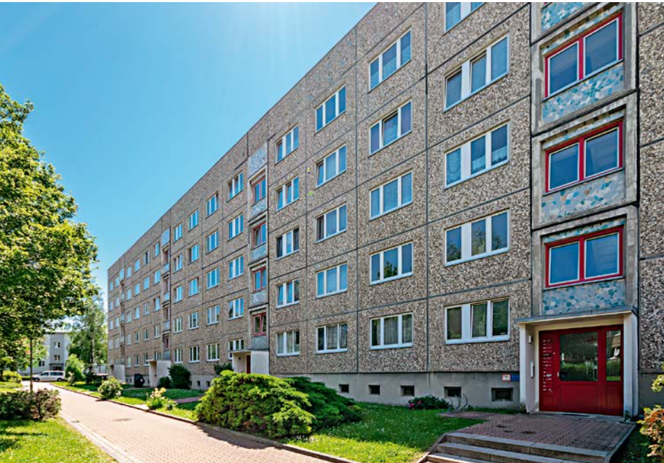
Der Plattenbau vor der Sanierung. Hier geht es künftig auch um eine Vereinfachung der Bewirtschaftung, denn der Solarstrom ermöglichte eine Pauschalmitte
