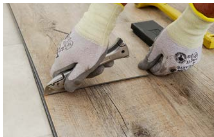
Leicht mit einem Verlegemesser zuschneiden lassen sich die Vinylbodenbeläge aus dem Hause Gerflor
