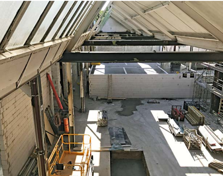
Beim Bau des Theaterzentrums wurde ein Haus-in-Haus-Konzept umgesetzt
