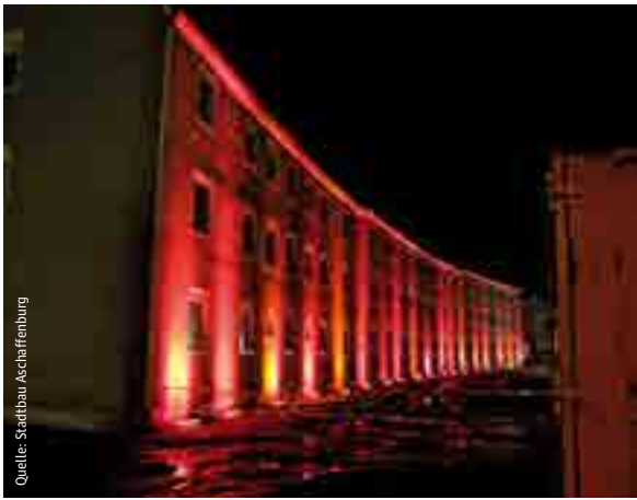
Quelle: Stadtbau Aschaffenburg Abschied mit Lichtershow: Nach dem Abriss entstehen in Aschaffenburg zentrumsnah 57 neue Wohnungen
