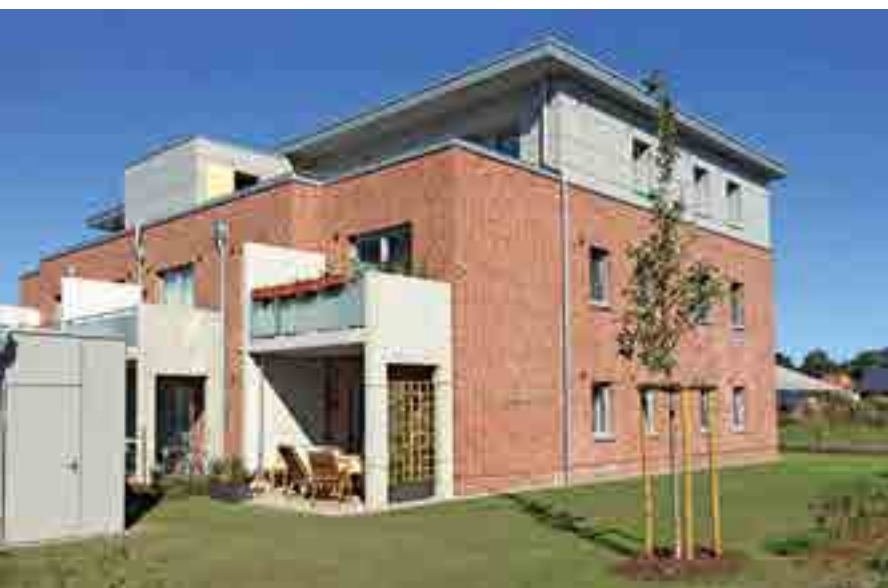
Auch in Rotenburg (Wümme) am Ammerländer Weg sind zehn Wohneinheiten mit etwa 720 m 2 Wohnfläche in Typenbauweise entstanden
