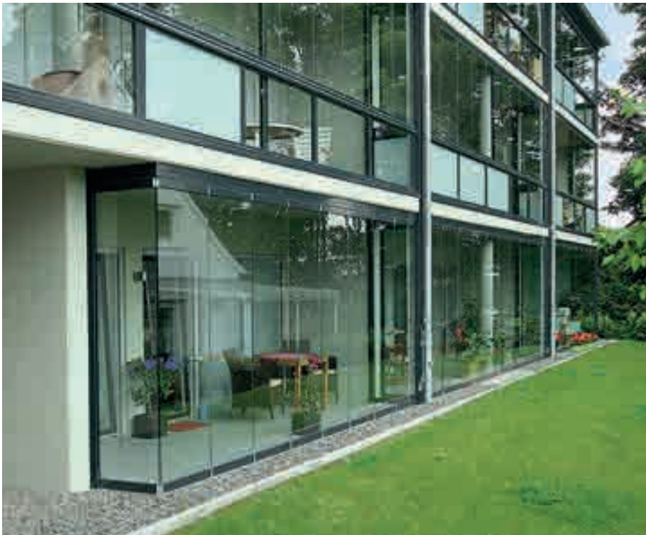
Im Parterre fiel die Wahl auf ein Ganzglas-Schiebe-Dreh-System. Die raumhohe Verglasung schafft transparente Räume und durch eine eingelassene Bodenschiene ist der barrierefreie Zutritt nach außen gewährleistet
