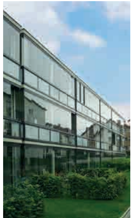
Teils aus gestalterischen, teils aus Gründen des Sichtschutzes wurden bei den Brüstungselementen satinierte und klare Folien gewählt
