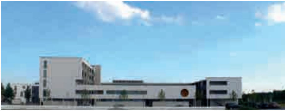
Fassadenansicht in Riem
