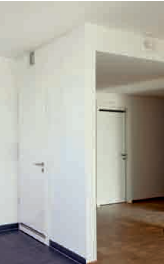
Eine Besonderheit bilden die unterschiedlichen Raumhöhen, die durch die Zu- und Abluftkanäle entstanden sind
