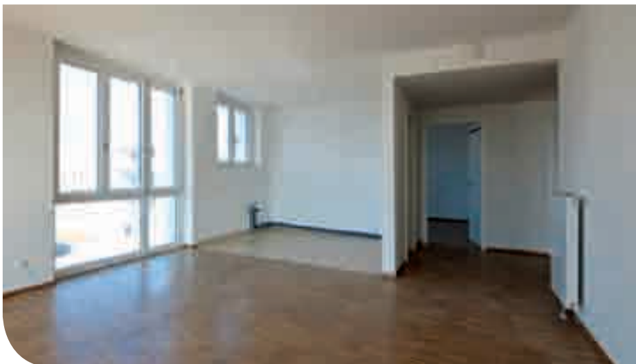
Die Wohnräume wurden von Lüftungskanälen freigehalten
