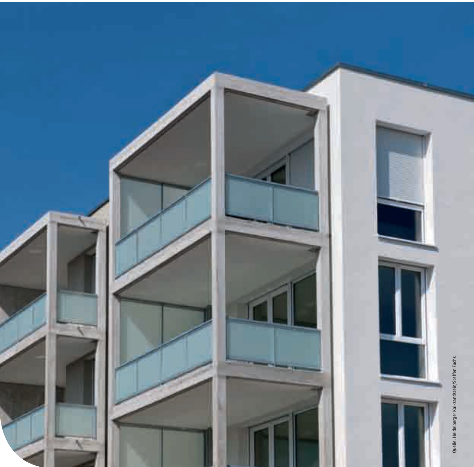
Fassadenansicht eines der beiden Mehrfamilienhäuser: Die Balkone wurden als separate Konstruktionen vor die Gebäude gestellt
