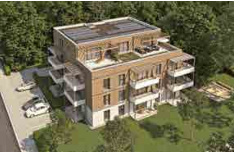
In der Heidelberger Kirschgartenstraße baut die Stiftung Schönau 14 Mietwohnungen in nachhaltiger Holzmodulbauweise – mit Holz aus den stiftungseigenen Wäldern
