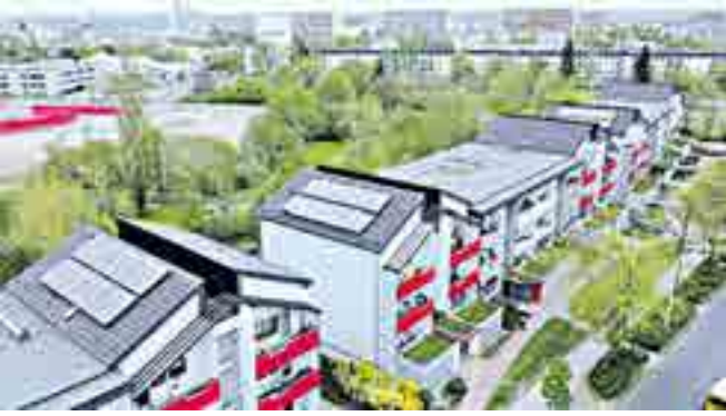
In der Neubrandenburger Kochstraße hat die Neuwoba ehemals fünfstöckige WBS 70-Zeilen teilerneuert und Gebäude mit einer völlig neuen Anmutung geschaffen
