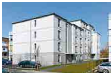
Beton wird vor allem für die Treppenhäuser und Fahrstuhlschächte verwendet, weil es hier hohe Ansprüche an Statik, Brand- und Schallschutz gibt
