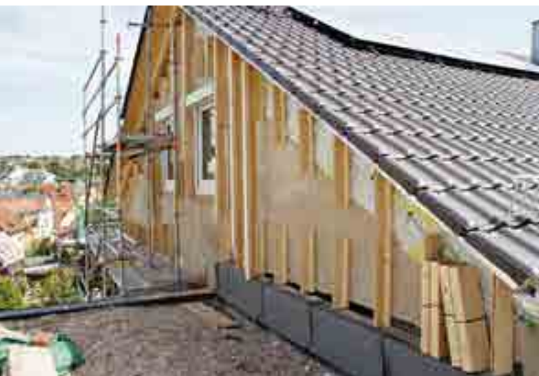
Fassadentaschen werden an die Außenwand angebracht
