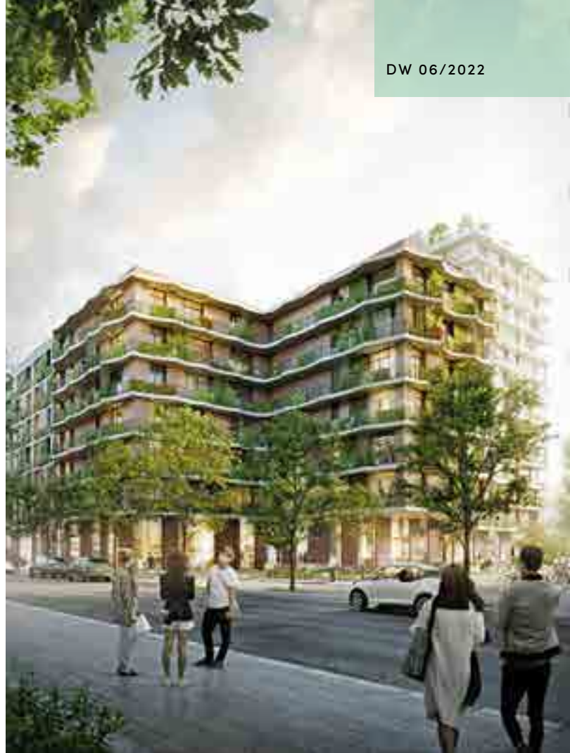
Durch die recyclingfähigen Baumaterialien ist der Cradle-to-Cradle-Gebäudekomplex „Moringa“ nahezu vollständig rückbaubar
