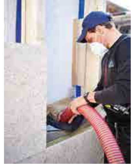
Die Fassadentaschen werden nach dem Anbringen der Holzplatten mit Einblasdämmstoffen wie Zellulose oder Mineralwolle verfüllt
