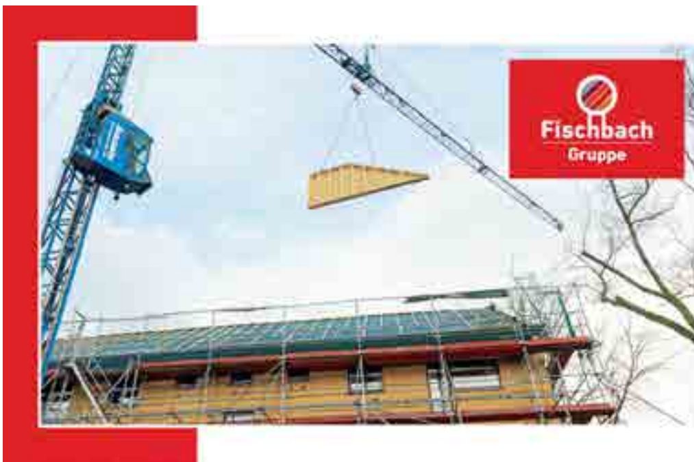
Mit Modularität zur Klimaneutralität – Die Fischbach Gruppe startet zusammen mit der Vonovia die serielle Sanierung von drei Mehrfamilienhäusern mitten in Bochum nach mit dem Energiesprung-Ansatz.
