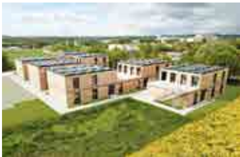
Bauvorhaben der Stadt Böblingen, 26 WE einer Flüchtlingsunterkunft, Holzbauweise, Fertigstellung: 5/2021, Hersteller: AH Aktiv-Haus GmbH
