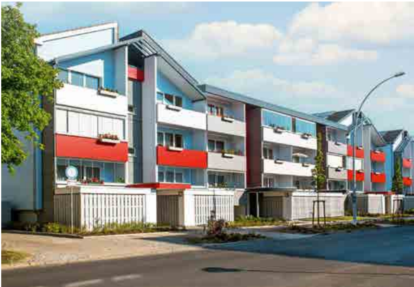
Die Neuwoba Neubrandenburger Wohnungsbaugenossenschaft eG hat fünfgeschossige Häuser auf drei Geschosse im bewohnten Zustand zurückgebaut und grundhaft modernisiert. Die neuen Dächer wurden mit einer Solarthermieanlage ausgestattet. Neben den Eingängen befinden sich nun Abstellmöglichkeiten. Die Häuser präsentieren sich neu strukturiert und farbenfroh
