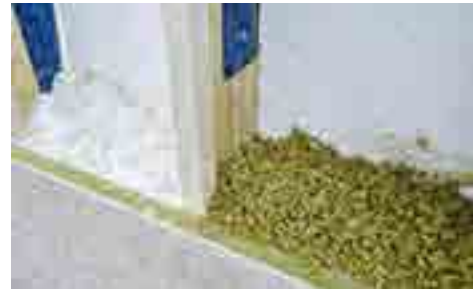
Die Außendämmung kann mit verschiedenen unbrennbaren Dämmstoffen ausgeführt werden: Steinwolle und Glaswolle-Einblasdämmung
