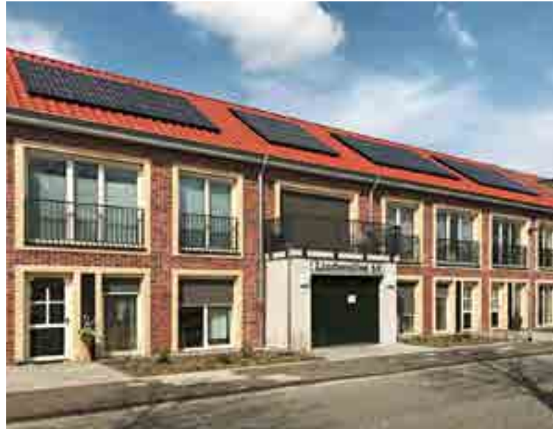
Bauvorhaben der GEWO Nordhorn, 9 WE (gefördert), Stahlbeton-Bauweise, Fertigstellung: 5/2021; Hersteller: Solidbox GmbH
