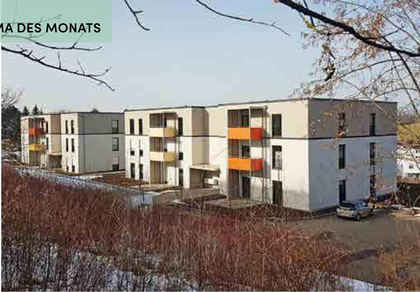
Alle Wohnungen in den beiden Serienhäusern der Städtischen Wohnungsbaugesellschaft Nordhausen verfügen über einen Balkon oder eine Terrasse
