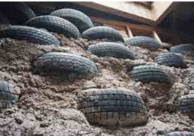
Wände aus Dreck und Autoreifen sind ein früher Klassiker des „Earthship“-Konzepts
