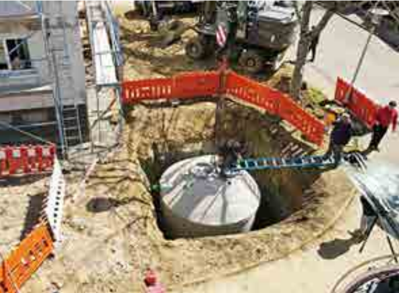
Anhand der Modernisierungsarbeiten an einem der WBG-Objekte (hier: Schluchseestraße Villingen-Schwenningen, Einbau eines Pellet-Silos) erklärt das Wohnungsunternehmen mit der „Sendung mit dem Haus“ auf einfache Weise, was bei einer Modernisierung passiert – zugunsten der Mieter und des Klimas
