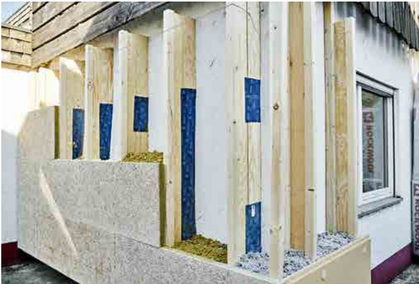
Nachdem die Fassadentaschen an die Außenwand angebracht wurden, werden die Dämmräume nach außen durch Holzplatten abgeschlossen
