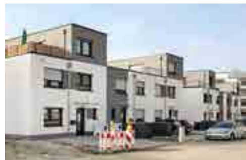
Bauvorhaben der GBW Bayreuth, 16 WE, Stahlbeton-Bauweise, 2/2021, Hersteller: Lechner Group
