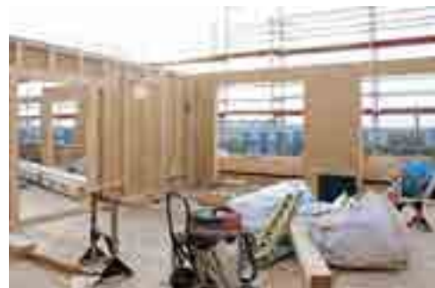
In einem Staffelfgeschoss in Holzbauweise entstanden vier neue Wohnungen, die die Bestandsgebäude erweitern
