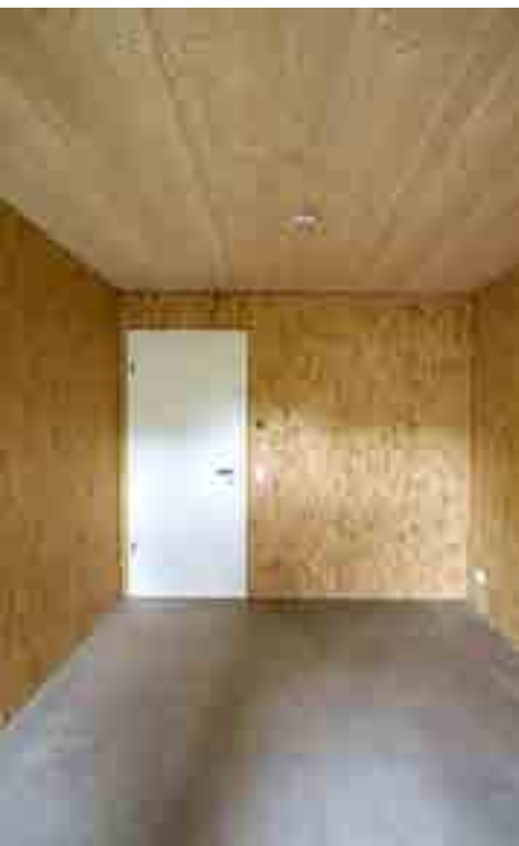
Esslingen Flandernstraße : Die Holzdecken-Untersichten und OSB-Oberflächen der Holzständerwände bleiben sichtbar
