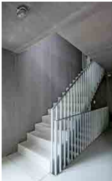
Esslingen Rohrackerweg: Aufgrund der Anforderungen des Brandschutzes werden im Treppenhaus zementgebundene Spanplatten verwendet
