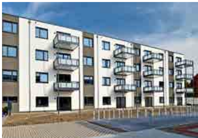
Aus 118 vorgefertigten Teilen entstand die neue Wohnanlage innerhalb von nur zwei Monaten
