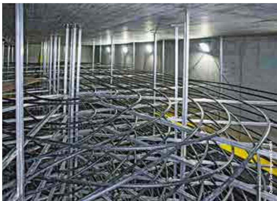
Blick ins Innere des von der Siedlungswerk GmbH in Stuttgart errichteten Eisspeichers
