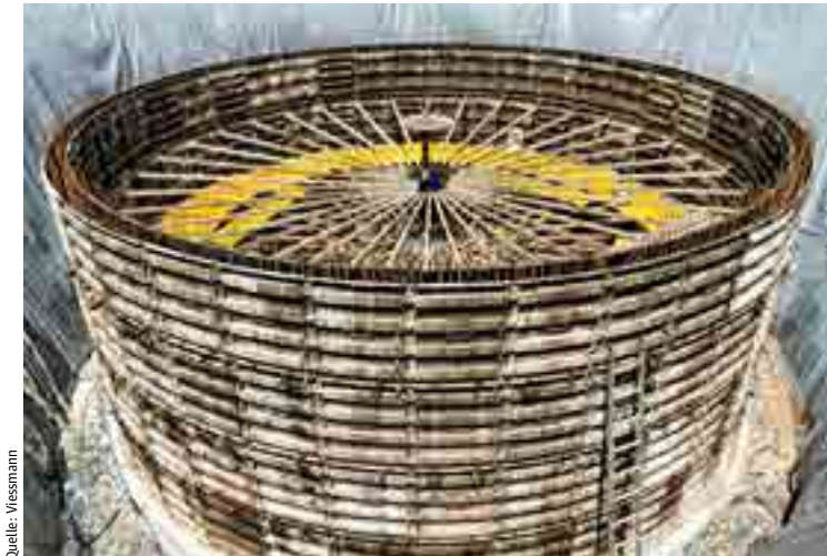
Einschalung für einen Eis-Energiespeicher. Die Abmessungen des Speichers werden nach der jeweils benötigten Leistung individuell berechnet
