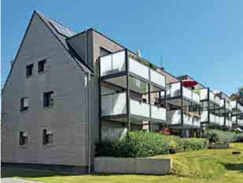
Mieterstromprojekte, wie hier bei der HWG eG in Hattingen, können die Nützlichkeit von Neubau- und Sanierungsmaßnahmen erhöhen. Ziel des ReConGeb-Projekts sind zuverlässige Erkenntnisse nach Gebäude- und Technologietypen
