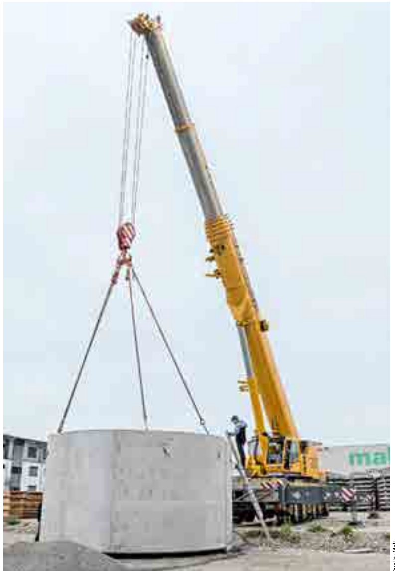
Verladen des Pelletspeichers in Einzelteilen auf LKW beim Hersteller Mall in Donaueschingen-Pföhren. Montage vor Ort im März 2016 mit Entnahmetechnik im Speicher durch den Hersteller
