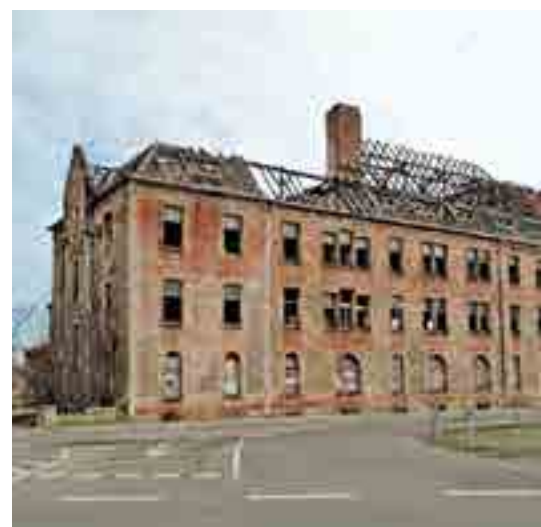
Das HaWoGe-Spielehaus vor der Sanierung
