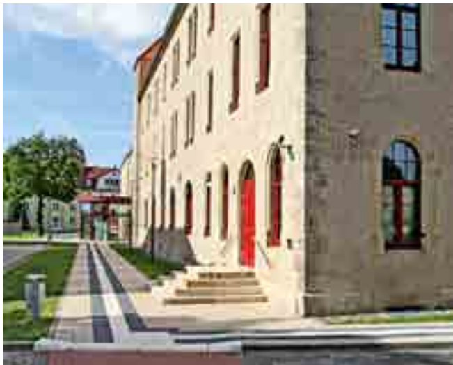
Außenbereich mit Blindenleitsystem
