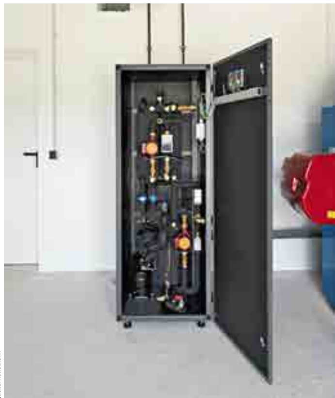
Übergabestation von kaltem Wärmenetz in Wohngebäude
