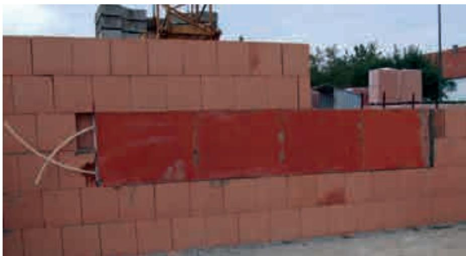
Flächenheizungselemente im Rohbau einer Ziegelwand
