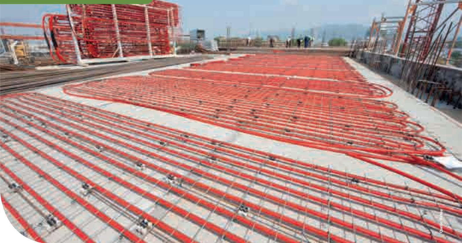
Das Stuttgarter Bülow Carré wird derzeit mit vorgefertigten Modulen zur oberflächennahen Betonkerntemperierung ausgestattet
