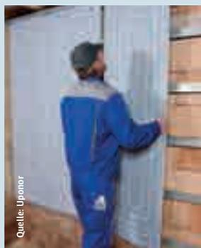
Das System Renovis wird montiert wie eine Trockenbauplatte
