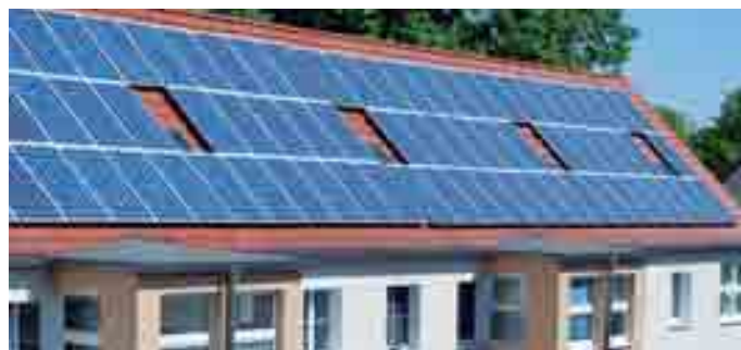
Auf insgesamt drei Dächern in der Biedenkopferstraße in Tegel-Süd hat die Berliner Energieagentur eine Photovoltaikanlage errichtet.
