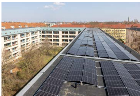
Photovoltaikmodule auf denkmalgeschützten Gebäuden? Das muss kein Widerspruch sein. Ein Ensemble der Vonovia SE zeigt, was geht.
