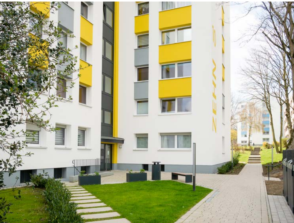
Der GWV Bochum investiert hohe Beträge in die Sanierung seiner Bestände. Die energetische Sanierung von 56 Wohneinheiten im Quartier Bussmannsfeld kostete mehr als 2,3 Mio. €
