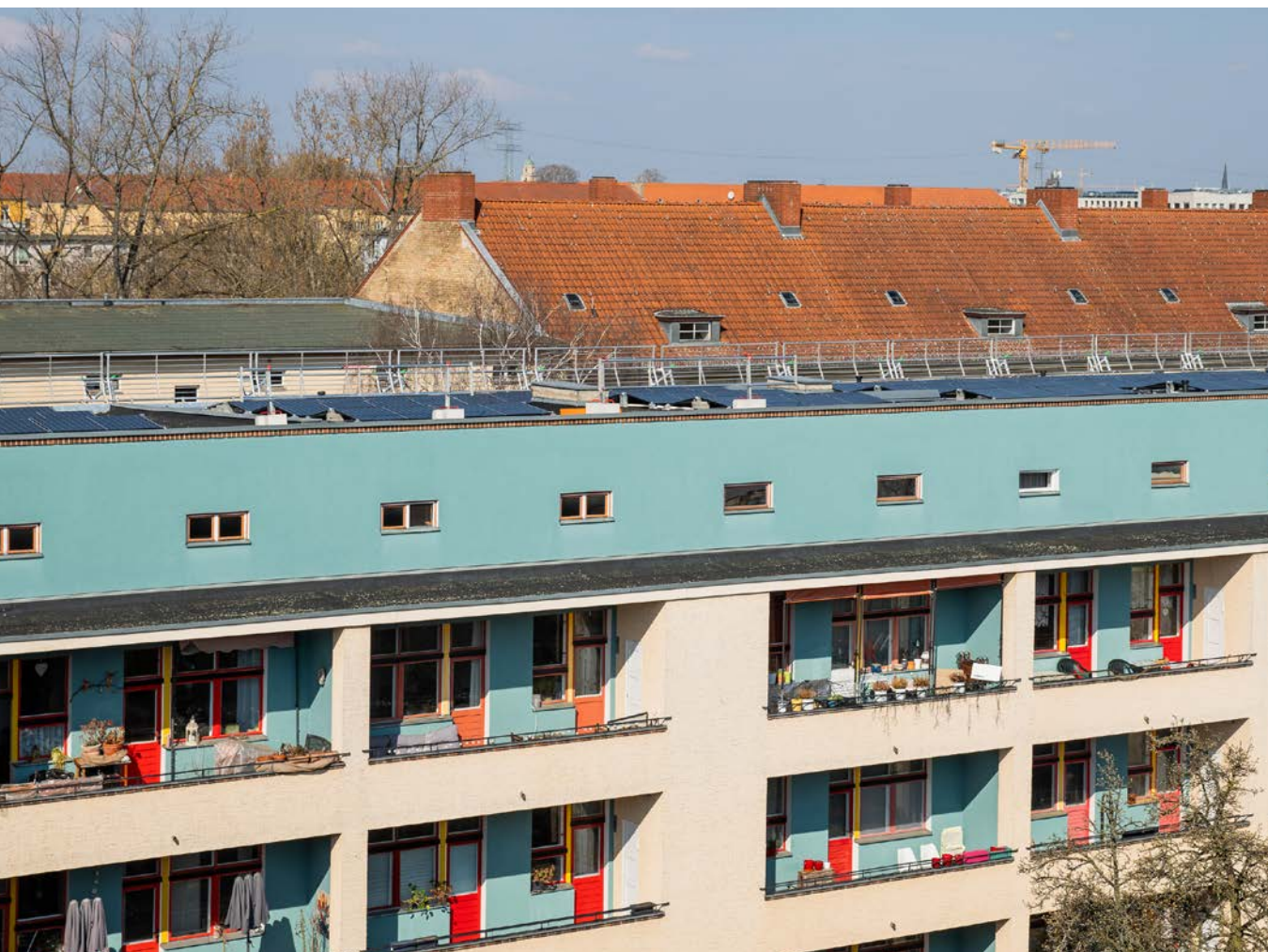
Vom öffentlichen Raum aus sind die PV-Module nicht zu sehen
