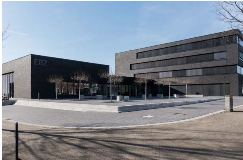
Dieser EBZ-Neubau in Bochum dient als Forschungs- und Demonstrationsplattform für digitale Gebäudetechnik
