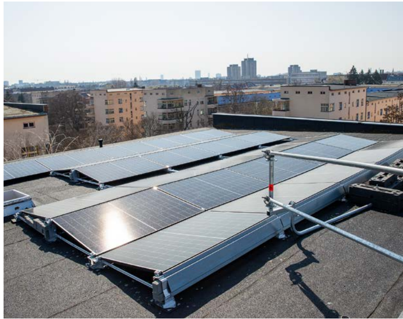
Obwohl die Wohnstadt Carl Legien unter Denkmalschutz steht, können handelsübliche Solarmodule installiert werden. Die Verkabelung ist clever in stillgelegten Schornsteinen versteckt
