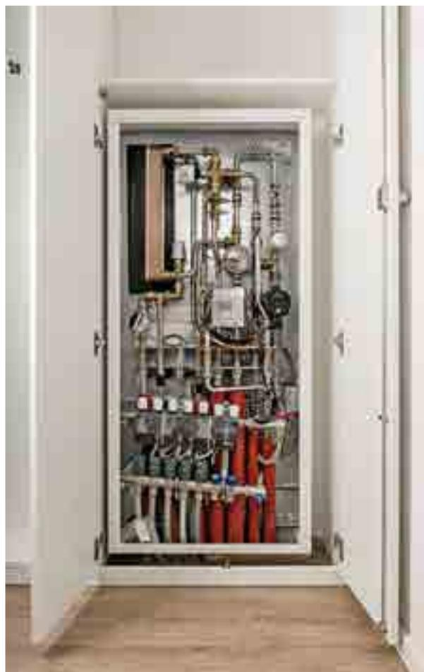
Pro Einheit übernimmt eine Wohnungsstation die bedarfsgerechte Wärmeversorgung und hygienische Trinkwassererwärmung. Unterhalb der Wohnungsstation befindet sich der Heizkreisverteiler. Die gesamte Technik verbirgt sich in einem Verteilerschrank, der wiederum im Wandschrank der Garderobe platziert ist
