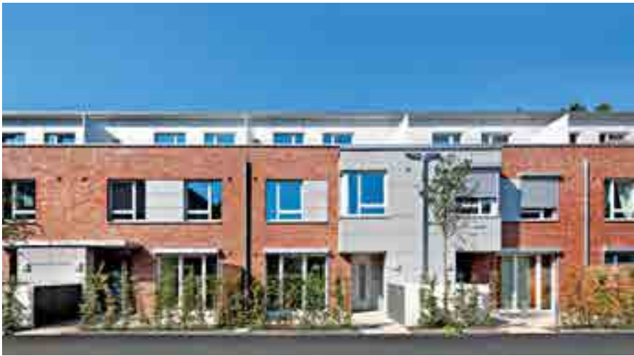
Erker, Staffelgeschoss und Fensterläden sind mit Fassadentafeln bekleidet
