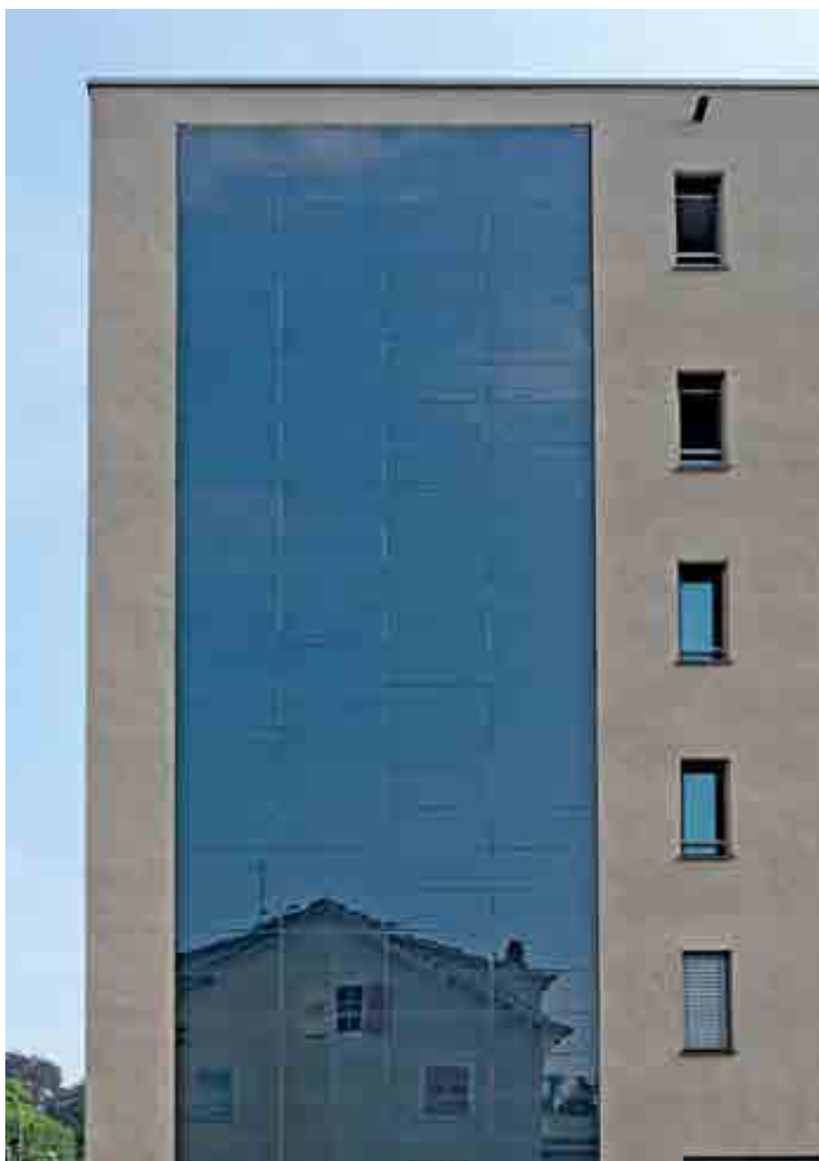
PV-Fassade am Projekt Niederfeldplatz der Städtischen Wohnbaugesellschaft Lörrach
