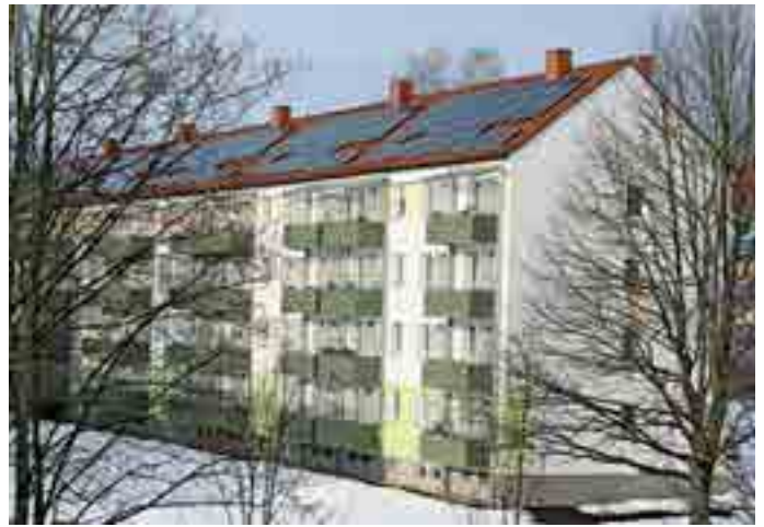
Photovoltaikanlagen auf einem Wohngebäude der CSg in der Alfons-Pech-Straße
