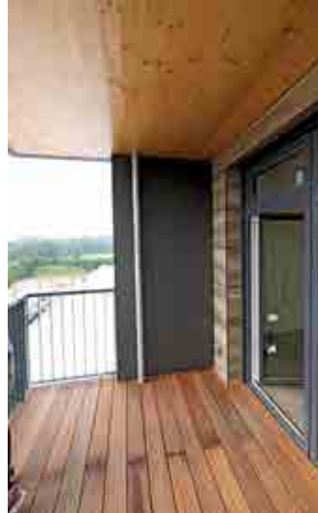
Die angehängten Balkone aus BSP-Elementen wurden an der Unterseite sichtoffen ausgeführt
