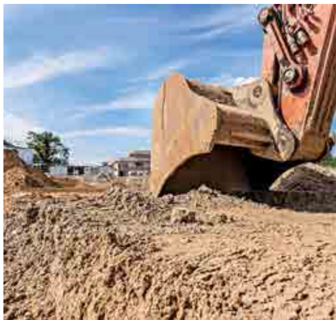
An der Neusser Wolberostraße hat der Bau 31 neuer Wohnungen begonnen
