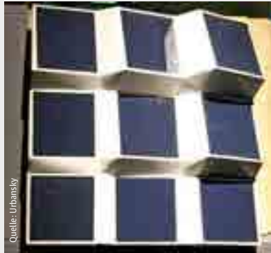
In Carbonbeton integrierte PV-Module
