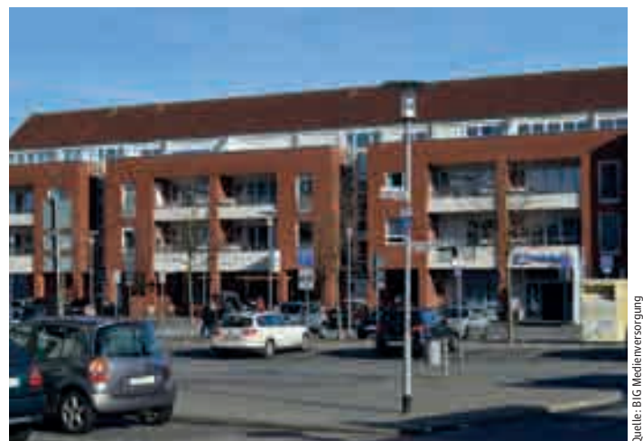
Unter diesem Platz laufen Glasfaserkabel entlang. Erdarbeiten waren nicht nötig
