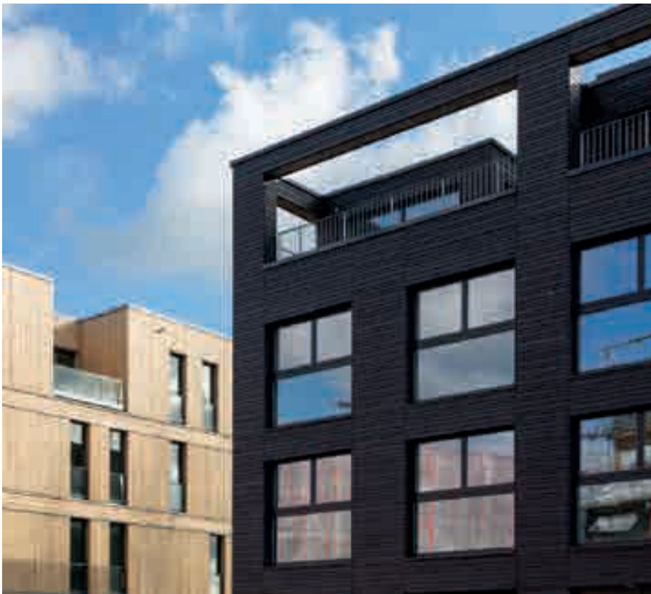
Das urbane Fertighaus Case Study # 1 (dunkel) und das Haus CSH Case Study Hamburg (hell) sind nach dem Baukastenprinzip und zu einem großen Teil aus dem Baustoff Holz erstellt
