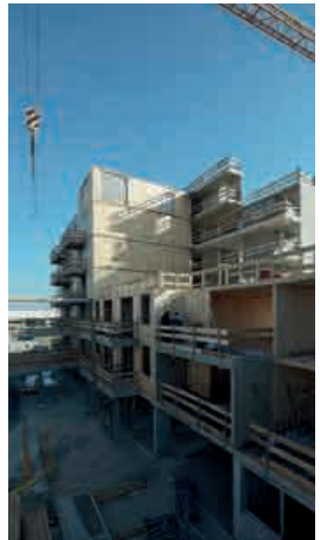
Massivholzelemente für die Wohnungstrennwände
