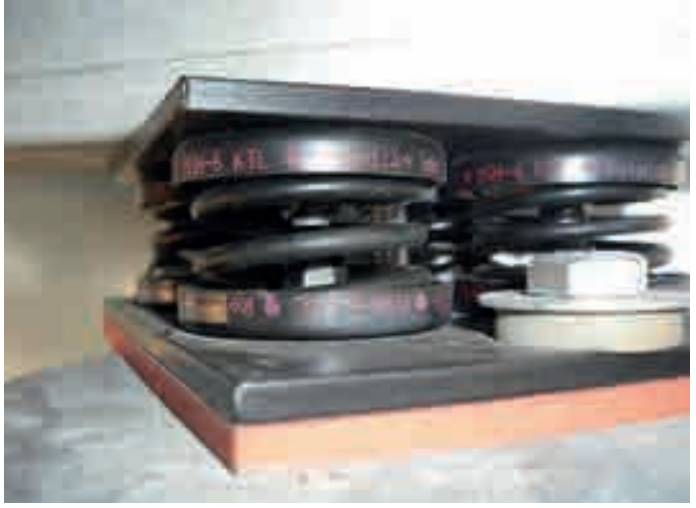
Mit Expertenhilfe wurde ein geeigneter Schwingungsdämpfer gefunden, der die Körperschallübertragung reduziert
