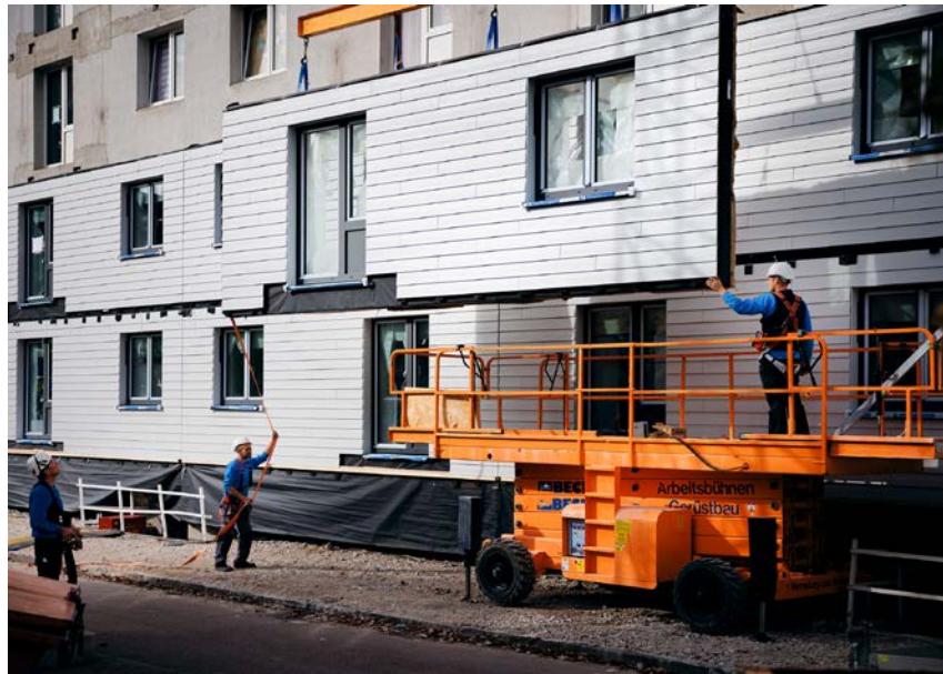
Der Mantageprozess industriell vorgefertigter Fassaden ist enorm schnell. Jedoch sind bei einer seriellen Sanierung noch eine Reihe handwerklicher Vor- und Nacharbeiten nötig, die es in eine optimierte Taktung einzupassen gilt
