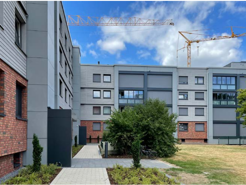
Einfach strukturierte Fassaden lassen sich einfacher sanieren. Doch auch für Fassaden mit Loggien, Balkonen, Fassadensprüngen und unterschiedlichen Materialitäten werden Lösungen angeboten
