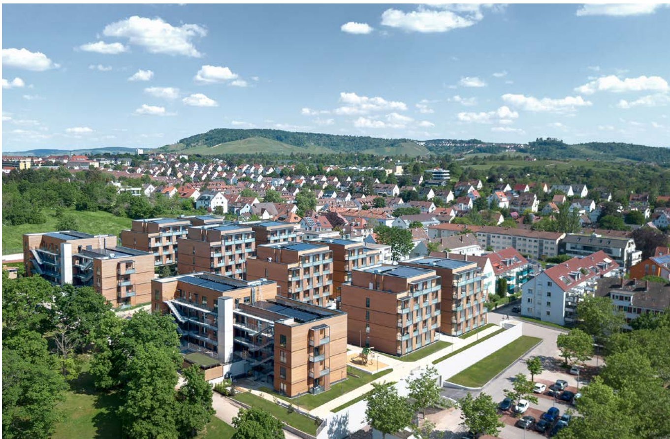
Aufnahme eines neuen Wohnquartiers, das die SWSG in Stuttgart-Bad Cannstatt für Klinik-Mitarbeitende realisierte. 330 Wohnungen in sechs Gebäuden wurden hier in Holz-Bauweise mit Raummodulen errichtet
