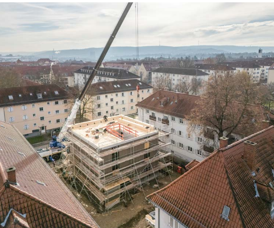
Das „SWSG_EQ 12 “ genannte Gebäude wurde entwickelt, um rasch mehr bezahlbaren Wohnraum schaffen zu können. Die quadratische Grundfläche von 12 m mal 12 m soll effizient und effektiv qualitativ hochwertigen Wohnraum ermöglichen
