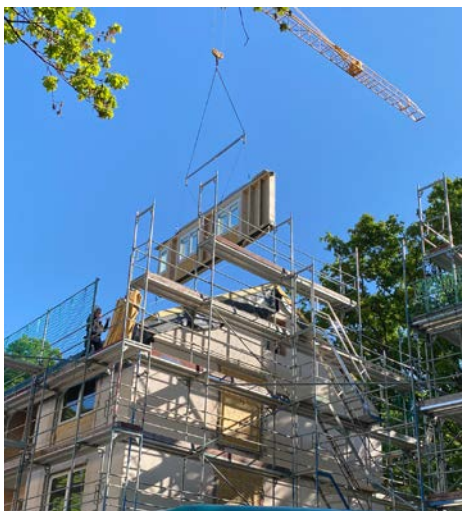
Im Rahmen der seriellen Sanierung konnte die Gewobau Marburg 48 Einheiten im laufenden Betrieb modernisieren
