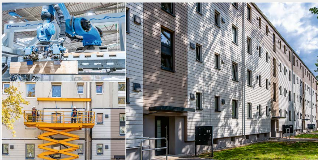
Fassadenmodule von ecoworks mit integrierten Fenstern und TGA: Schlanker Aufbau, schnelle Montage, verkürzte Bauzeiten und hohe Ausführungsqualität.
