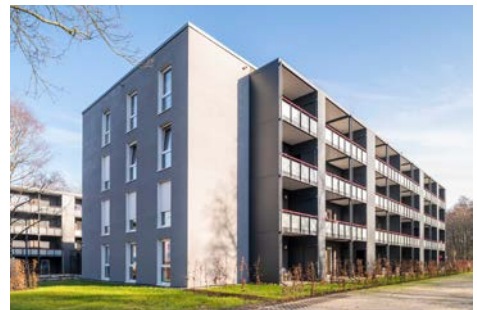
Die Wärmeversorgung im Quartier erfolgt per Fernwärme. Bei allen neu gebauten Typenhäusern befindet sich die Wärmeübergabe im Gebäude
