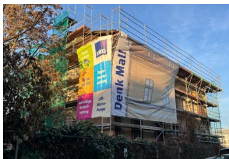
Nach langem Leerstand wird das Baudenkmal Hafenstraße 7 von der Halleschen Wohnungsgesellschaft mbH saniert
