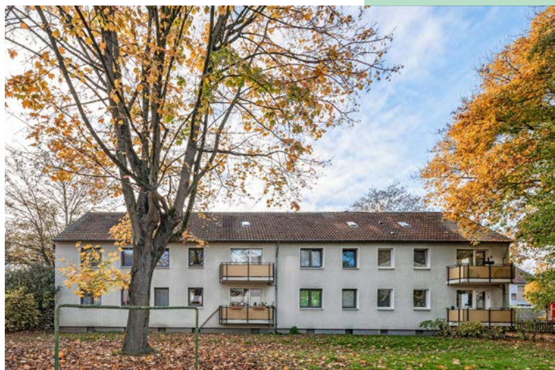
Bis 2028 wird die ehemalige Eisenbahner-Siedlung in Dortmund durch Modernisierungsmaßnahmen nachhaltig umgestaltet
