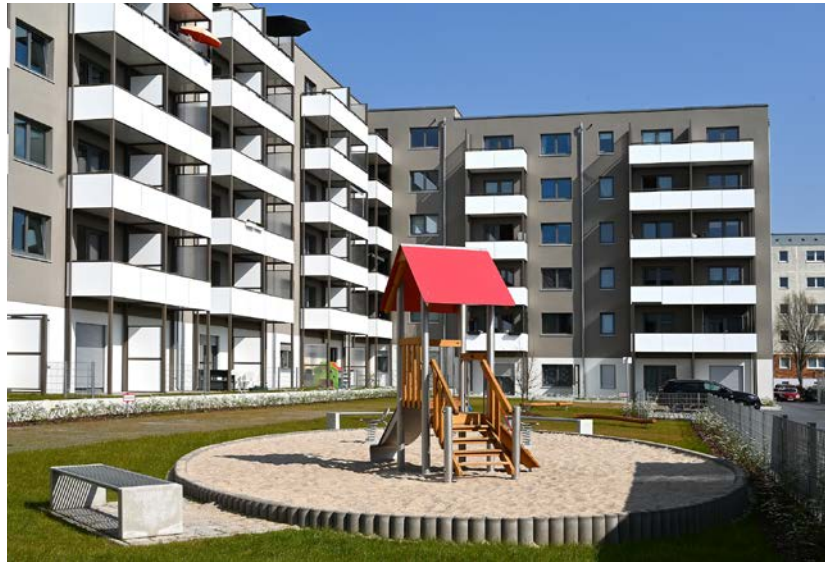
Der Prototyp des Typenhauses wurde Ende 2017 entwickelt; die Entwicklungszeit betrug nur dreieinhalb Monate. Die Grundsteinlegung erfolgte im April 2018. Im Dezember 2019 wurden die 165 Wohnungen in der Schkeuditzer Straße fertiggestellt
