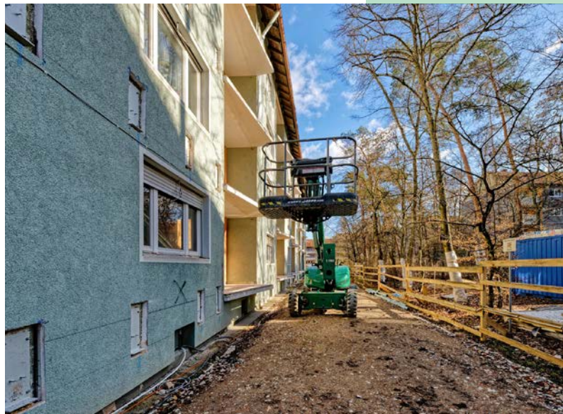
Auf stählernen Winkeln werden die neuen Fassadenmodule montiert, ohne die veraltete Dämmung komplett zu entfernen
