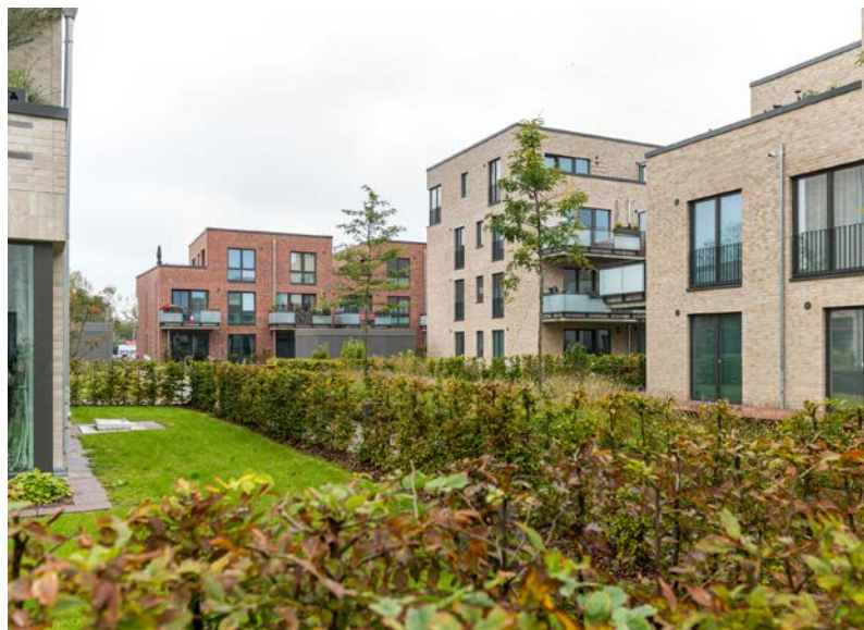
Dank eines gemeinsamen Gestaltungsleitfadens wird ein stimmiger Gesamteindruck gewahrt – trotz unterschiedlicher Architekturbüros. Für eine angenehme Aufenthaltsqualität im Quartier sorgt das viele Grün
