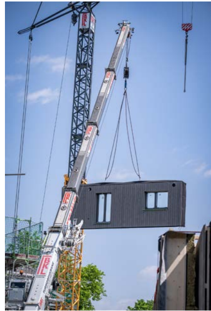
Sichtbares Zeichen einer seriellen Sanierung sind die „fliegenden“ Fassaden. Neben Kranarbeiten sind andere Montagearten möglich
