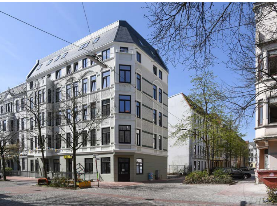
Die Stäwog engagiert sich in Bremerhaven bei der Revitalisierung. Sie sanierte unter anderem das Haus Goethestraße 45, in dem seit 2018 ein Atelier, eine Galerie, ein Coworking-Bereich und barrierefreie Wohnungen für junge Menschen untergebracht sind
