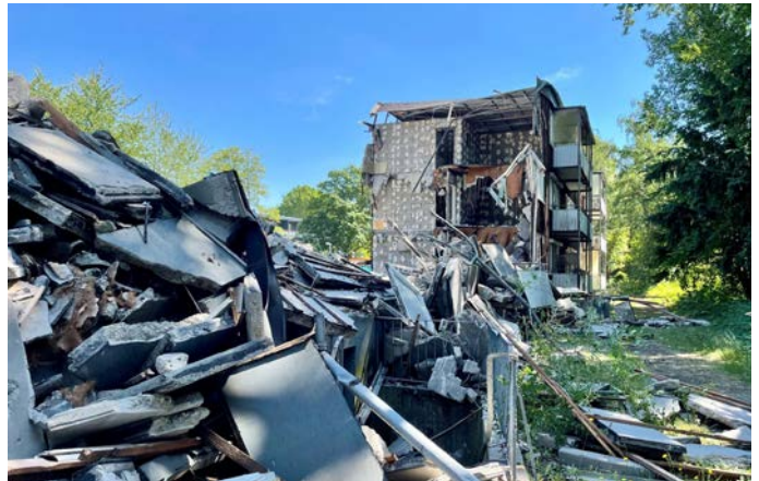
Die in Stahlskelettbauweise errichteten Werkswohnungen der Hoesch AG waren mit vertretbarem Aufwand nicht sanierbar und wurden abgerissen
