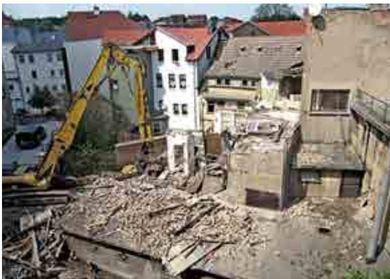
Die historischen Gebäude wurde samt Nebengebäuden noch durch den Voreigentümer - die städtische BGG - abgerissen
