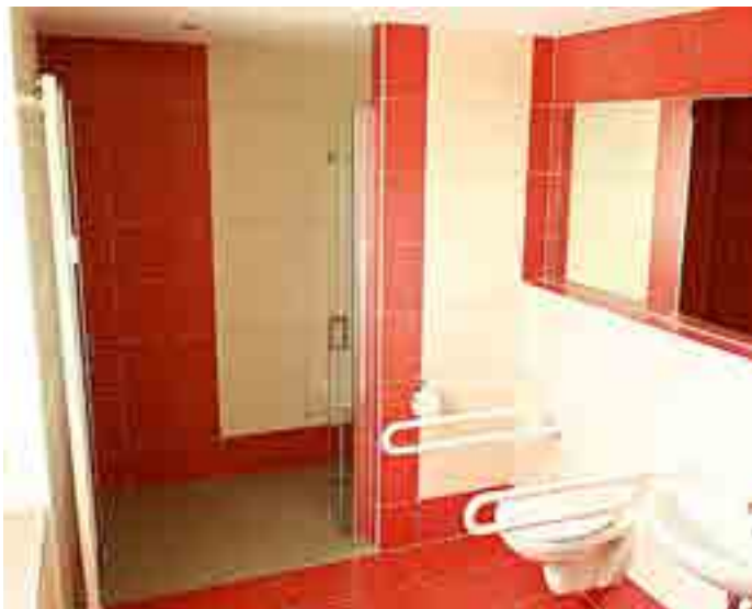
Altengerechter Wohnraum: Die Wohnungsgenossenschaft „Fortschritt“ Döbeln eG stattet u. a. die Bäder mit einer ebenerdigen Dusche und Haltegriffen aus
