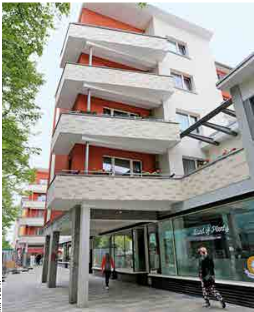
Charakteristischer Laubengang nach der Sanierung: Riemchen an den Balkonen und am Quertrakt, abgestützte Balkone, Dämmung an der Fassade und unter dem Dach
