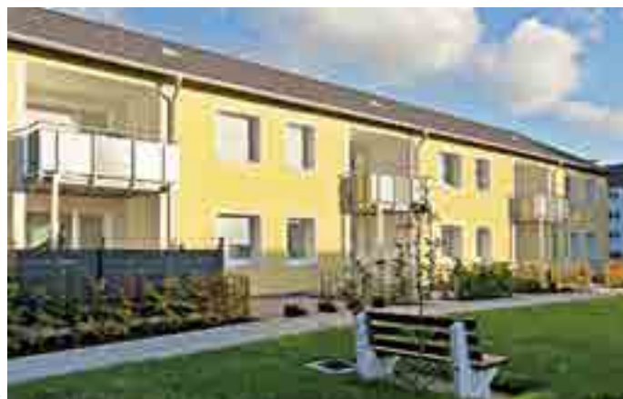
Sanierungsobjekte in Dinslaken
