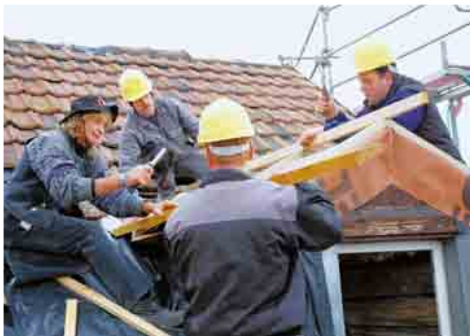
Qualifizierung am Bau. Mitarbeiter der „Bauhütte“ helfen beim Dachdecken.
