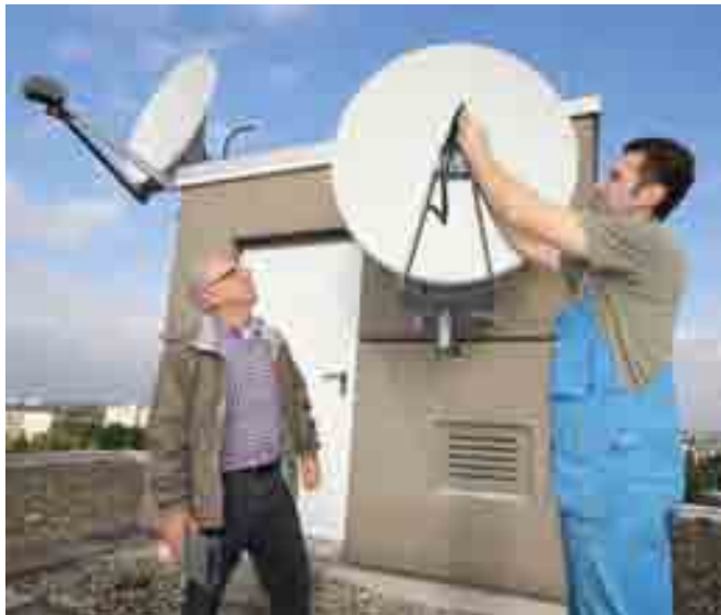
Alfons Ott (l.) Projektleiter der Immoservice Mühlheim GmbH, und ein Mechaniker bei der Endkontrolle der beiden großen Schüsseln auf dem Dach, die viele kleine Schüsseln an den Hausfassaden und Balkonen ersetzen.
