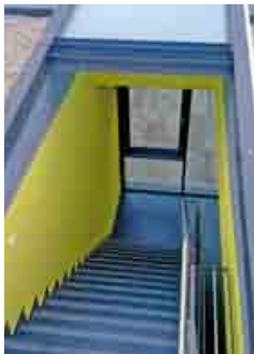
Im Brandfall stellt ein Dachausstieg einen sicheren Rettungsweg dar.
