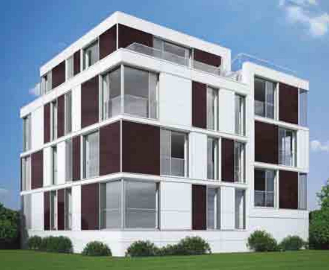
Stadthaus am Ostseefjord Schlei in Schleswig: Blick auf Nord- und Westseite. Quelle: Schüco International KG
