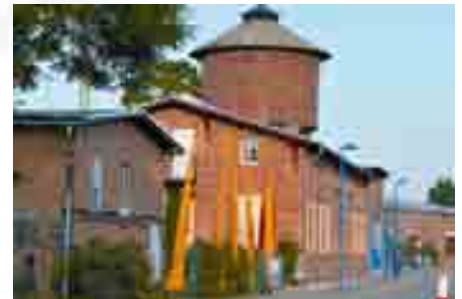
Kulturhof und Wasserturm des Gleis 3 Kulturzentrums Lübbenau, links die künftige „Bunte Bühne“.
