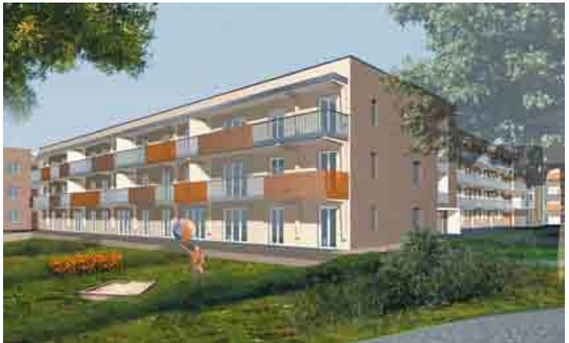
Im Bild das südliche Gebäude des Wohnquartiers mit seinen vorgelagerten Mietergärten. Die Balkongrößen liegen zwischen elf und 19 Quadratmetern.
