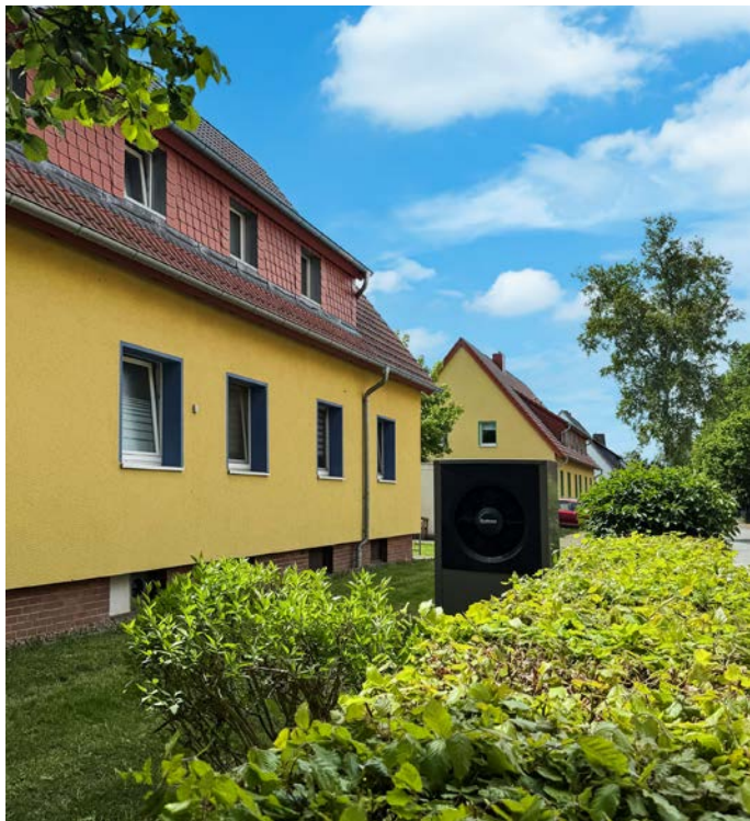
Diese Siedlungshäuser der GSW verfügen nun über eine dezentrale Versorgung mit Luft-Wasser-Wärmepumpen
