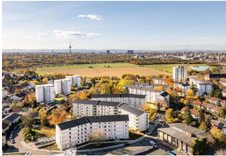
Die Siedlung der GBG am Adolf-Damaschke-Ring im Mannheimer Stadtteil Feudenheim galt bei ihrem Bau als Musterbeispiel des sozialen Wohnungsbaus
