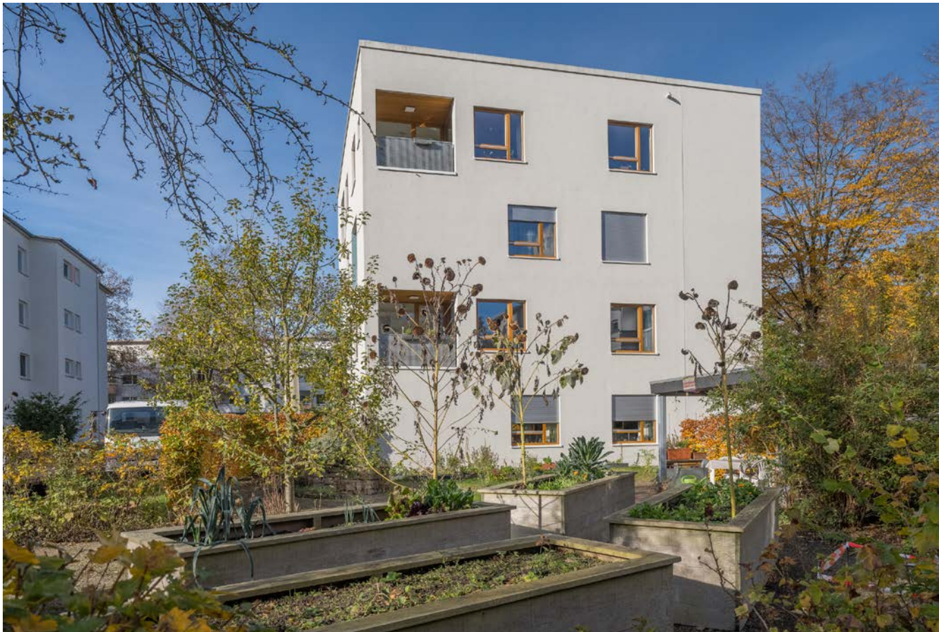
Die Mietergemeinschaft dieses Gewoba-Neubaus kann künftig für die Bewässerung ihres Gartens das gesammelte Regenwasser nutzen und dadurch Trinkwasser sparen
