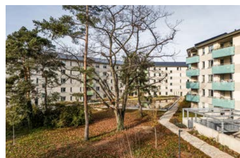
Drei Gebäude wurden abgerissen und zusammen mit den Anlagen des Wasser- und Ressourcenmanagements auf einer Tiefgarage neu errichtet
