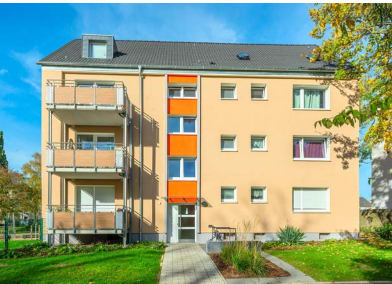
Modernisiert wurde nicht nur das Wohnumfeld: Die Gebäude erhielten eine Dämmung, neue Fenster und neue Eingangstüren
