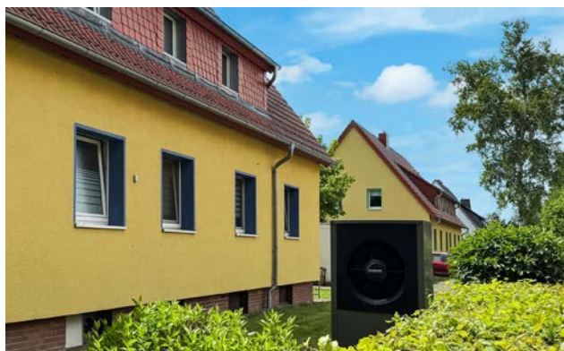
Wärmepumpe statt fossile Heizung und massive Gebäudedämmung: Der aktuelle Praxisbericht der „Initiative Wohnen.2050“ bestätigt den Trend zur Dekarbonisierung der Energieerzeugung.
