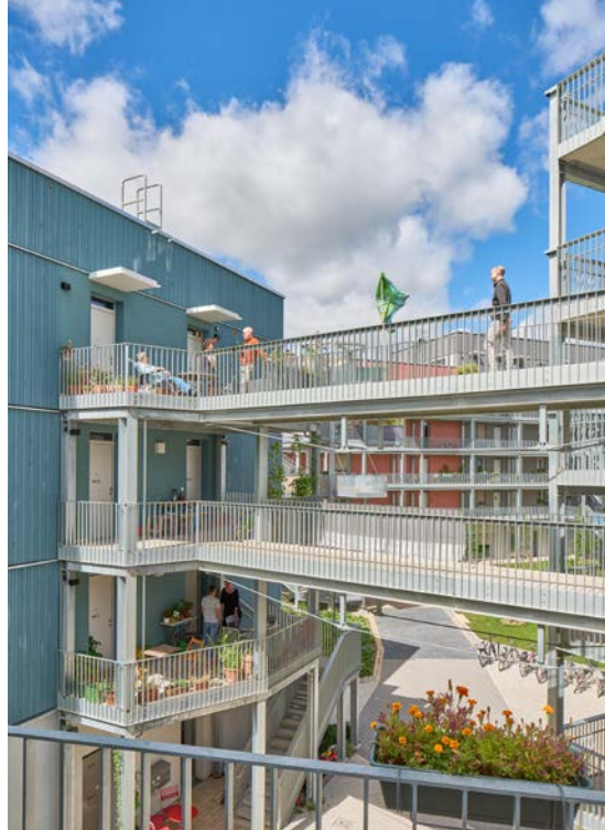
Außenliegende Treppenhäuser und Laubengänge dienen als Verbindungspunkte
