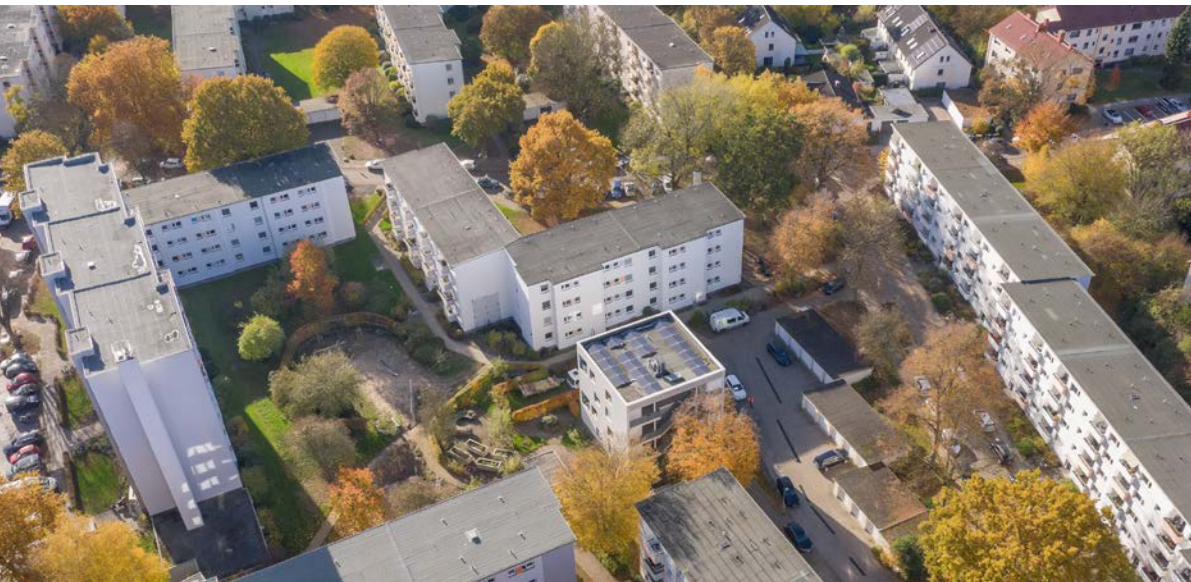
Das Gewoba-Quartier in der Gartenstadt-Süd während der Neupflanzungs- und Installationsmaßnahmen
