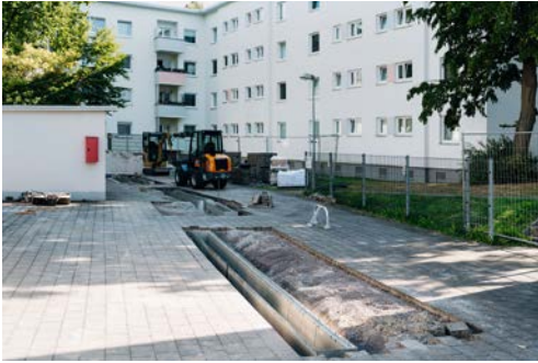
Einbau von Filtersubstratrinnen, die das Regenwasser von Reifenabrieb und Verschmutzungen reinigen
