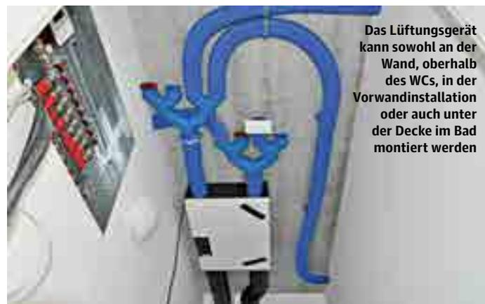
Das Lüftungsgerät kann sowohl an der Wand, oberhalb des WCs, in der Vorwandinstallation oder auch unter der Decke im Bad montiert werden
