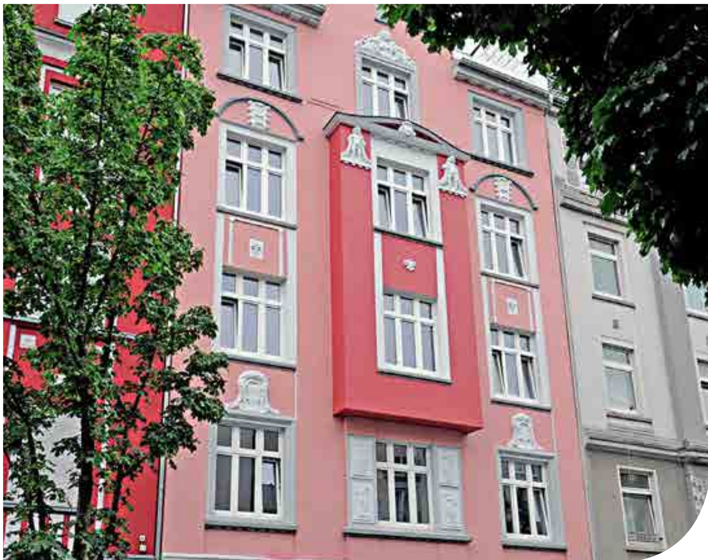
Ein Schmuckstück in der Nordstadt: das Gebäude Brunnenstraße 51 nach der Modernisierung. Die Maßnahmen hatten Signalwirkung, bald zogen weitere Immobilienbesitzer nach...
