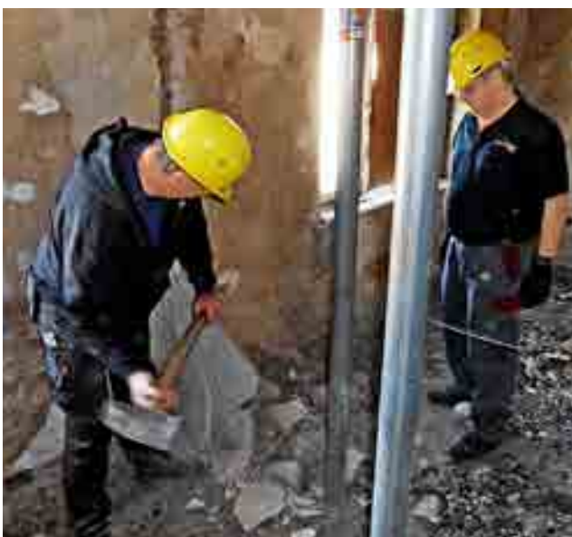
Der Beschäftigungsträger setzte gezielt Langzeitarbeitslose und lokale Handwerksfirmen für die Arbeiten ein
