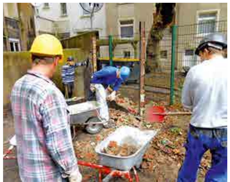
In Haus und Hof wurde kräftig aufgeräumt, entrümpelt und abgerissen – u. a. wurden Mauern und Balken entfernt, diverse Matratzen weggeschmissen
