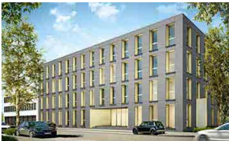
In Mannheim-Neustadt entsteht eine Art „moderner Plattenbau“. Der Gewerbebau wird in Betonsandwich-Bauweise mit R-Beton errichtet
