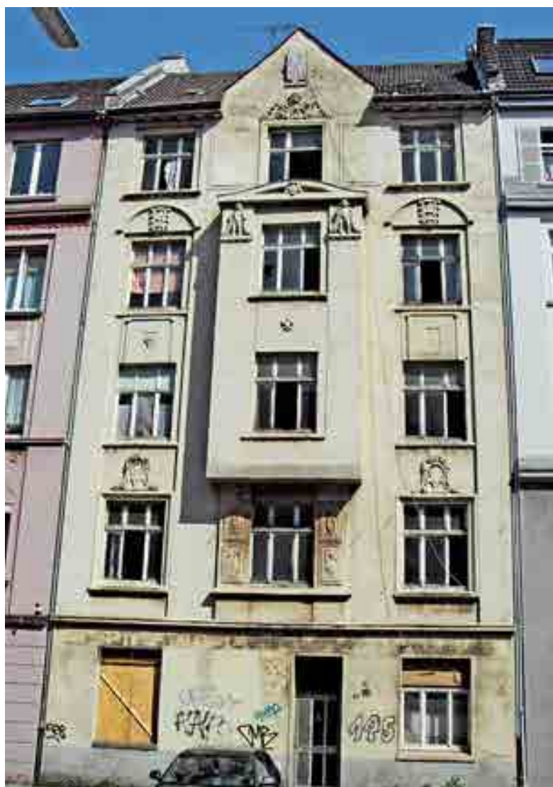
Leerstand, kaputte Fenster und Verwahrlosung kennzeichneten die sog. Problemimmobilie. Oft gab es Polizeieinsätze am Haus ...
