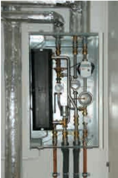
DOGEWO21 entschied sich für die dezentrale Wärme- und Trinkwasserversorgung mit Wärmeübergabestationen
