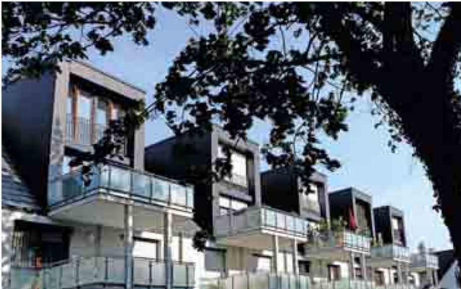
Im zweiten Bauabschnitt entstehen hochwertige Maisonettewohnungen.
