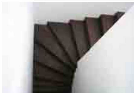
Treppe vor und nach der Sanierung.
