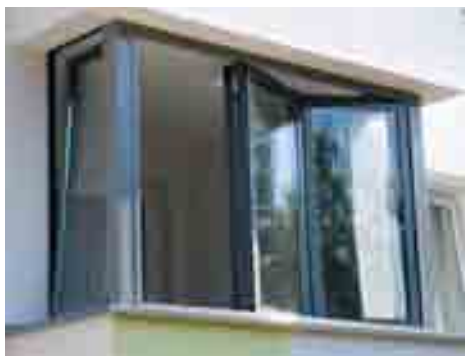
Die Glaselemente lassen sich über die gesamte Fensterfront öffnen.
