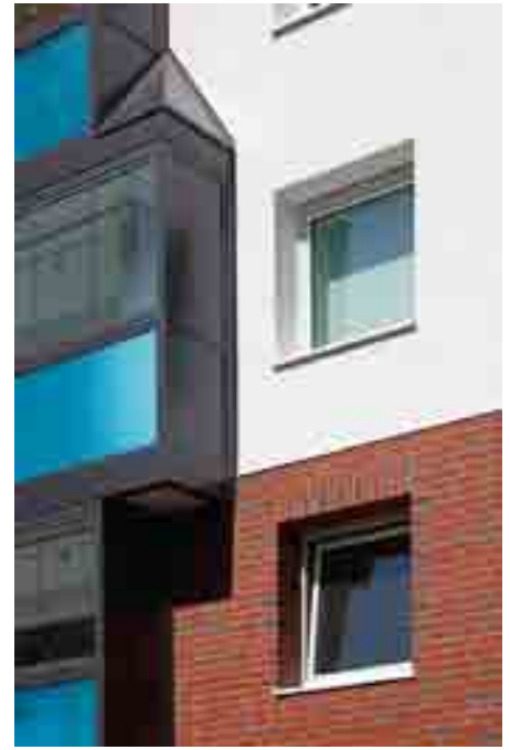
In dem Mehrfamilienhaus an der Lappenbergsallee in Hamburg wurden 59 Wohneinheiten mit einem integrierten Lüftungssystem ausgestattet. Zum Lärmschutzkonzept gehören auch eine Schallschutzverglasung und verglaste Balkone. Quelle: Schüco
