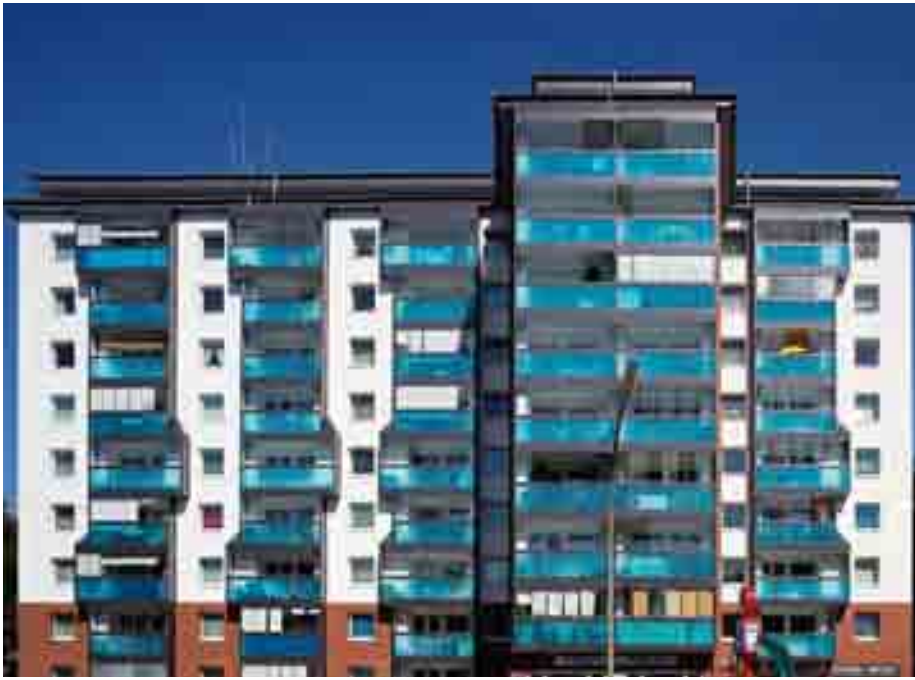
In dem Mehrfamilienhaus an der Lappenbergsallee in Hamburg wurden 59 Wohneinheiten mit einem integrierten Lüftungssystem ausgestattet. Zum Lärmschutzkonzept gehören auch eine Schallschutzverglasung und verglaste Balkone. Quelle: Schüco
