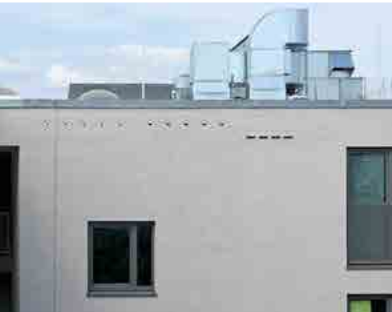
In die Fassaden der drei Gebäude wurden Nisthilfen integriert. Links fünf Nisthöhlen für Spatzen, in der Mitte fünf für Mauersegler, rechts vier für Fledermäuse
