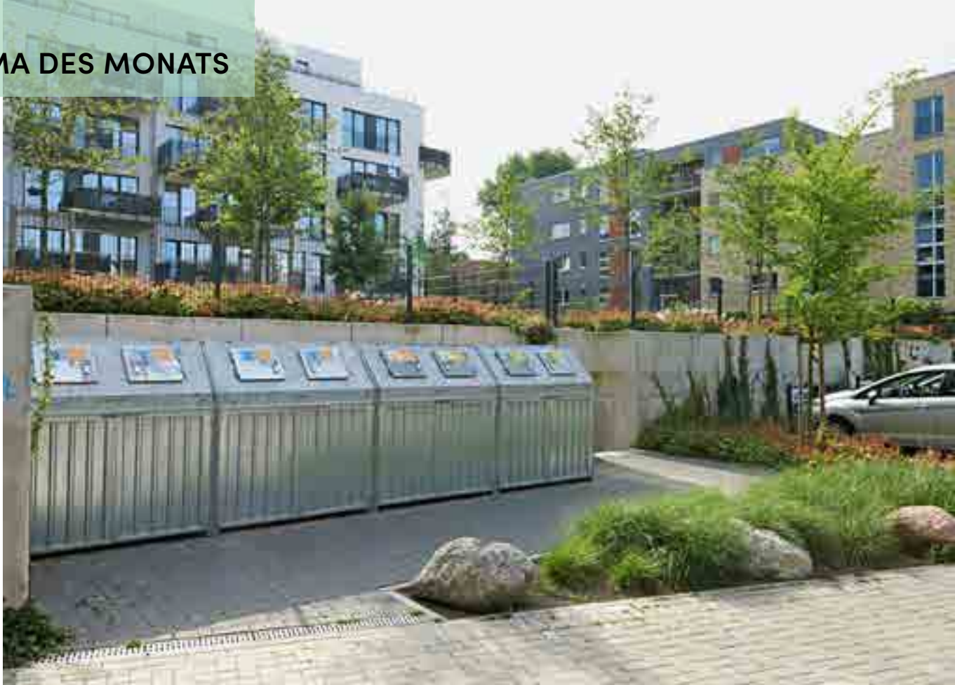
Die Platzierung und Einbindung der Müllbehälter in die Außenanlagen kann helfen, Fehlbefüllungen sowie Ärger rund um die Entsorgung zu minimieren und die Qualität der Außenräume positiv zu beeinflussen
