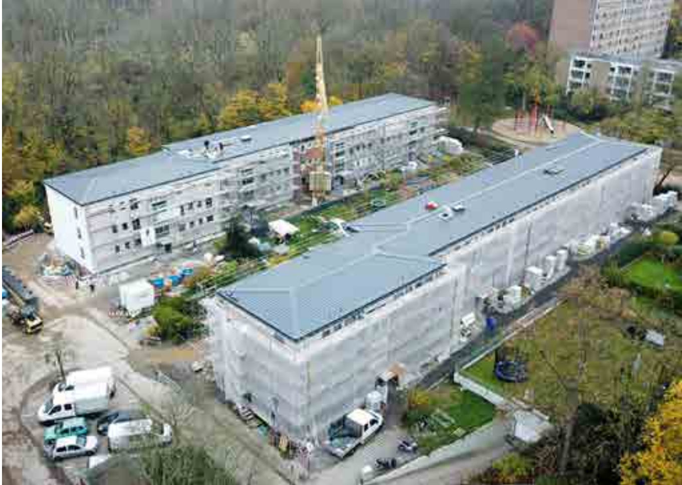
Stand der Modernisierungsmaßnahmen in der Jakob-Kneip-Straße Ende 2021, Blick von Südwesten
