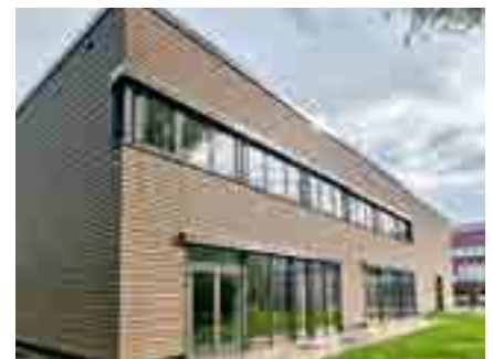
Zum dauerhaften Schutz vor ungeliebten Graffiti sind die keramischen Elemente von Tonality mit einem integrierten Graffitienschutz ausgestattet
