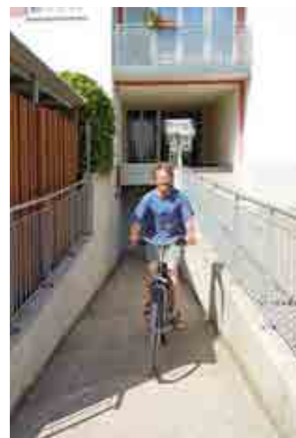
Flache, rutschsichere Rampen sind zur Erschließung von Fahrradkellern ideal. Davon profitieren auch Rollstuhlfahrerinnen oder Kinderwagenschieber
