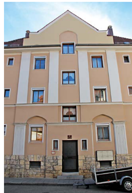
Architektonische Details prägen die Fassaden. Aus bauhistorischer Sicht verbietet sich damit der Einsatz eines Wärmedämmverbundsystems
