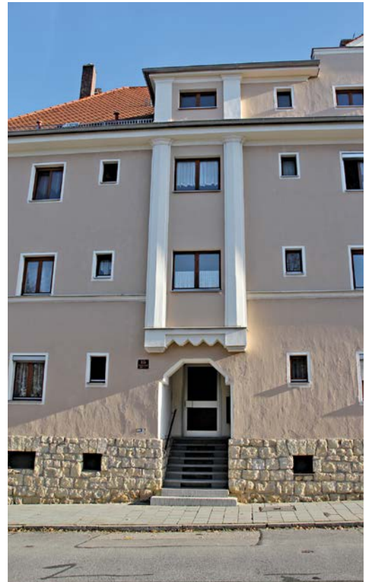
Detailaufnahme eines Hauseingangs, wie er für Genossenschaftssiedlungen der Zwischenkriegszeit typisch ist
