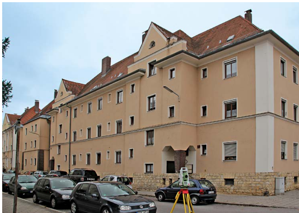
Umlaufende Gesimse und Natursteinsockel symbolisieren den genossenschaftlichen Zusammengehörigkeitsgedanken
