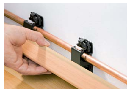
Mit einem Klicksystem werden Sockelleisten montiert, die Rohre und Leitungen verdecken
