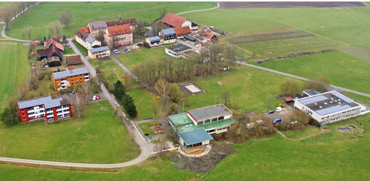
Der Gebäudebestand des kleinen Dorfes ist über mehrere Epochen hinweg gewachsen. 1,5 Mio. € bezahlte die Genossenschaft für die gesamte Anlage
