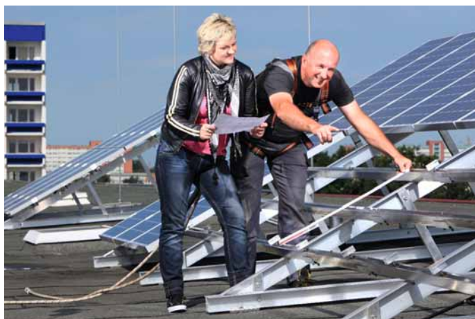
Installation neuer Fotovoltaikanlagen im Rostocker Nordwesten.
