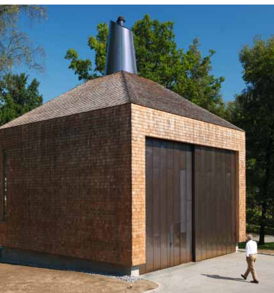
Die „Heizkone“, ein gefällig gestaltetes Holzschnitzelkraftwerk, welches auch in Wohngebieten nicht störend auffällt. Quelle: B & O
