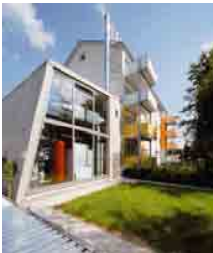
Die Holzhackschnitzelheizanlage im Heizhaus ist durch das Glasfenster gut zu sehen.
