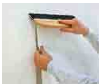
Die Relieftapete StoTap Infinity lässt sich einfach im Wandklebeverfahren verlegen. Quelle: Sto AG
