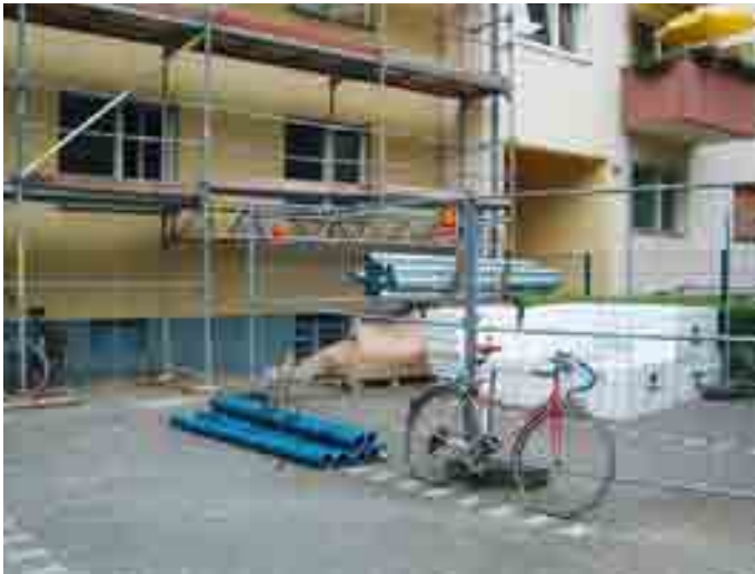
Abgegrenzte Flächen für die Materiallagerung garantieren Ordnung und Sauberkeit.
