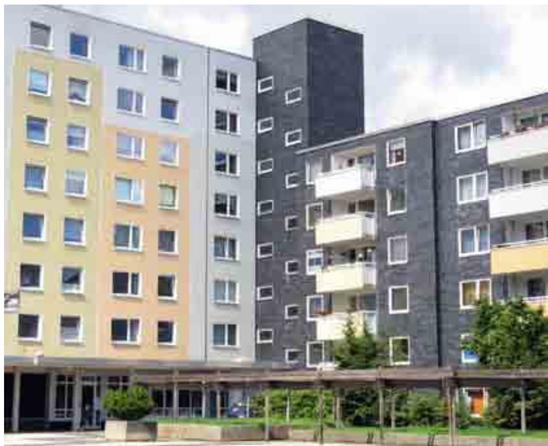
Modernisierte Wohnungsbestände am Brunnenplatz in der Bochumer Hustadt.
