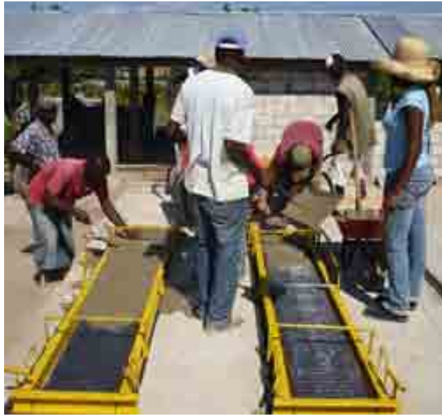
Die Vorfertigung von Bauelementen ist nach kurzer Ausbildung im Land möglich.
