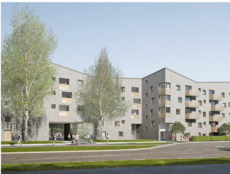
Die neu gebauten Häuser an der Bremer Straße im Hamburger Bezirk Harburg haben fünf Etagen und jeweils einen Aufzug
