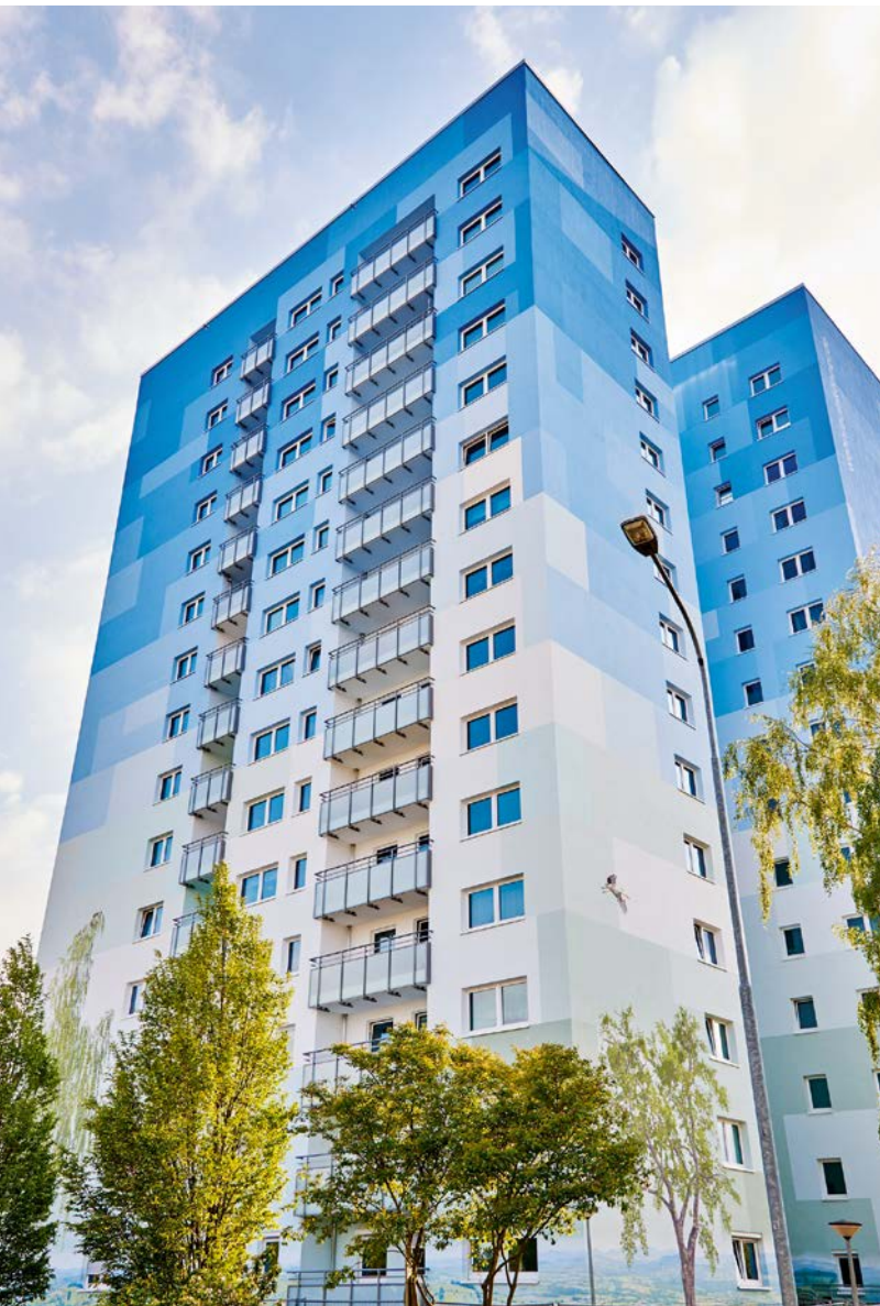
Wohnhochhaus der Baugenossenschaft Langen eG in der Feldbergstraße 35 nach der Modernisierung. Durch die Sanierung wurde der Heizenergieverbrauch um mehr als 50 % reduziert
