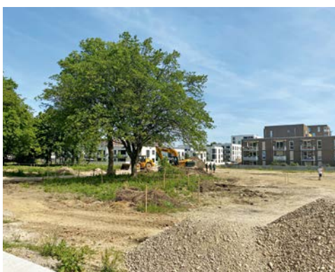
Bauland ist knapp und teuer. Bei Wohnungsbauvorhaben sind auch die vergaberechtlichen Rahmenbedingungen zu berücksichtigen
