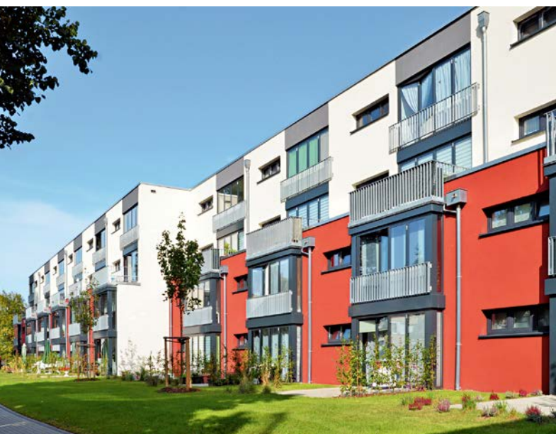
Rückseite der GSW-Objekte Edithstraße/Helgastraße in Minden jeweils vor (2011) und nach der durchgeführten Modernisierung (2020)
