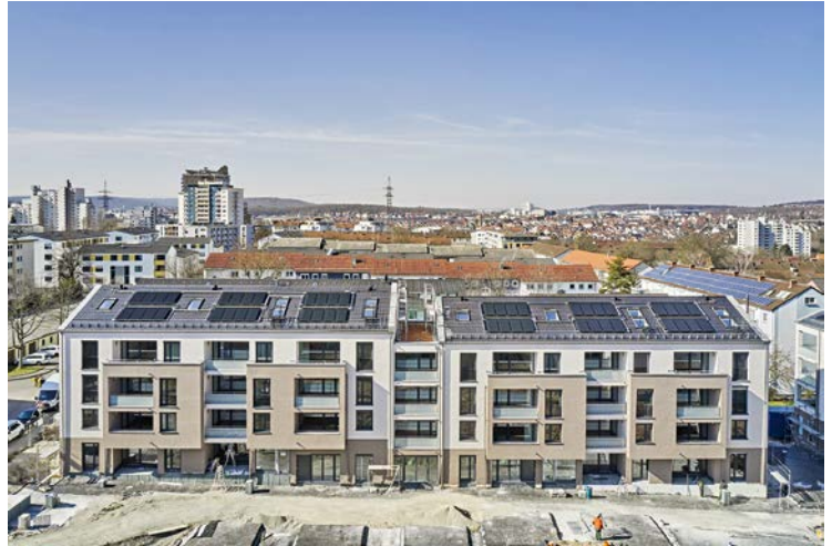
Im Rahmen des geförderten Projekts „Reallabor Wohnen – resilient und generationengerecht für alle in Stuttgart-Rot“ entstand eine inklusive Wohngemeinschaft
