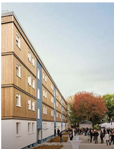
Sieht gut aus, ist aber zu aufwendig: Beim nächsten Projekt will die VBW Bochum auf die verputzten Felder über den Hauseingängen verzichten
