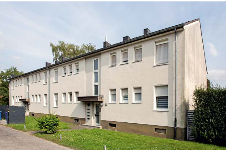
26 baugleiche Wohngebäude aus den 1950er Jahren mit 111 Wohnungen lässt die LEG in Mönchengladbach von vier Unternehmen sanieren
