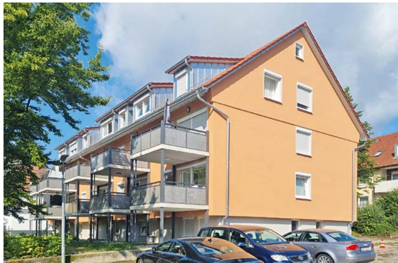
Bei zwei im Energiestandard KfW 55 erstellten und 2019 in Betrieb genommenen Häusern mit elf Wohnungen der GWG Schwäbisch Hall in der Eduard-Schüler-Straße wurde eine Gas-Wärmepumpen-Kombination gewählt, da Fernwärme nicht bis zu den Objekten zu verlegen war
