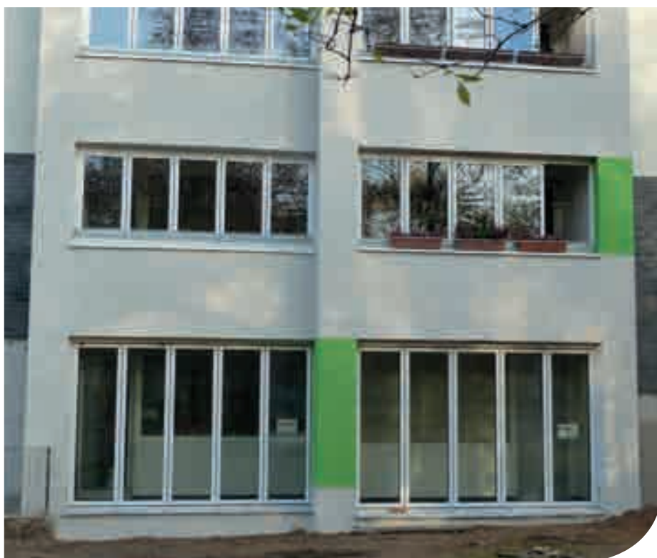
In den Erdgeschosswohnungen wurden raumhohe Glas-Faltwände verbaut
