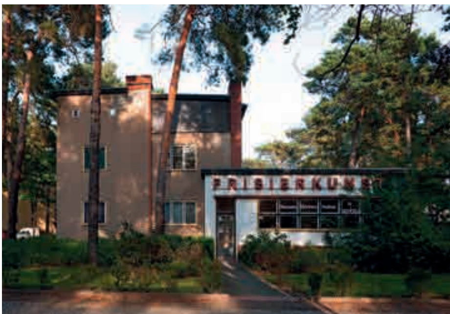
Ein Wohnhaus und eine Gewerbeeinheit in der Riemeisterstraße im Zustand vor der Sanierung. Die Gewerbeeinheit wird nach der Sanierung von einem Architekten genutzt – doch der Schriftzug „Friseurkunst“ bleibt erhalten
