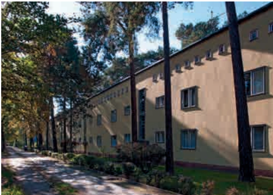
Um die filigrane Fassadengestaltung des Baudenkmals nicht zu gefährden, kommt eine Außendämmung nicht in Frage
