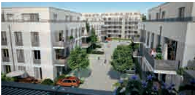
Visualisierung des Neubauprojekts in Berlin Alt-Hohenschönhausen mit fünf Baukörpern
