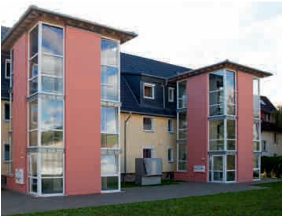
Auf der Rückseite entstanden zwei neue Treppen- und Aufzugstürme, um die bis zu 100 m 2 großen Wohnungen auch altersgerecht erschließen zu können. Dazwischen aufgestellt die Luft/Wasser-Wärmepumpe, die die Fußbodenheizung in den Wohnungen mit Heizungswasser speist
