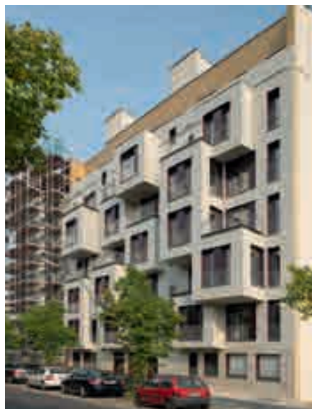
Mit sandfarbenen Faserzementplatten verkleidete Fassade, unterschiedlich weit hervortretende Erker beleben die Straßenseite
