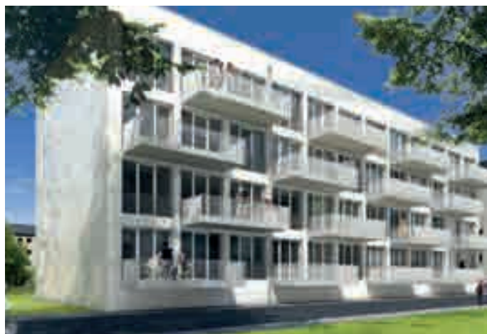
Im Rahmen des ausgezeichneten Projekts der Gewofag in München sind u. a. vier Passivhäuser entstanden.
