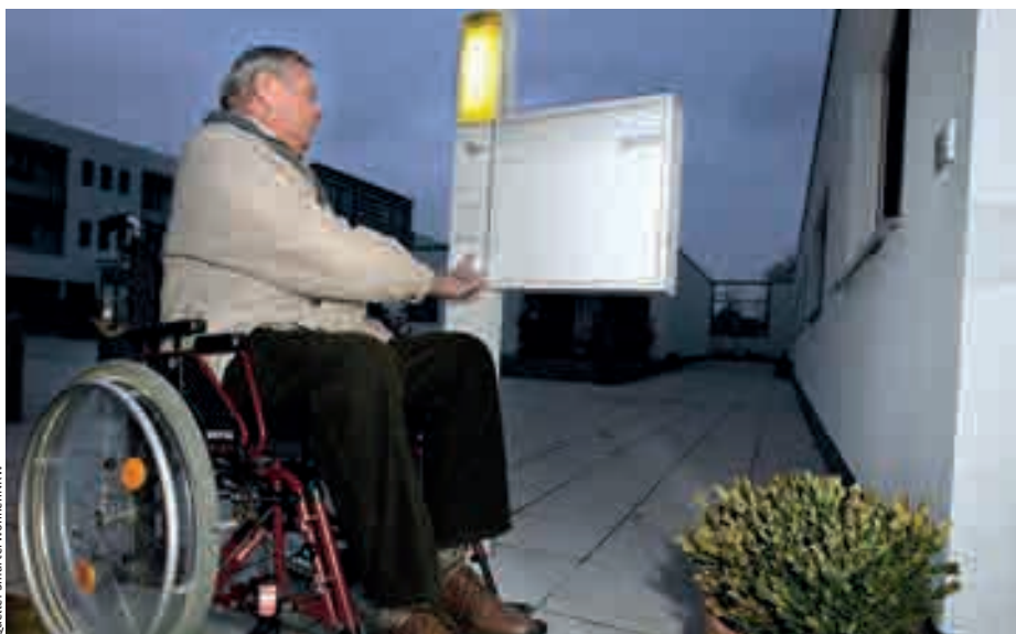
Fingerscan-Öffnungssystem einer im Rahmen der Modellprojekts SmarterWohnenNRW umgerüsteten Wohnung der HWG Hattingen.
