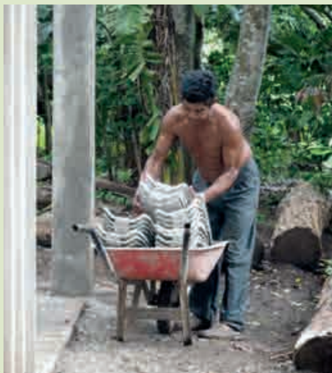
Fachkräfte aus den umliegenden Dörfern bauen die Familienhäuser, mindestens ein Familienmitglied arbeitet mit. Beim Bau werden Wandfertigteile und Mikrobeton-Dachziegel verwendet.
