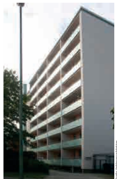
Ansicht des Seniorenwohnhauses Westphalweg 7
