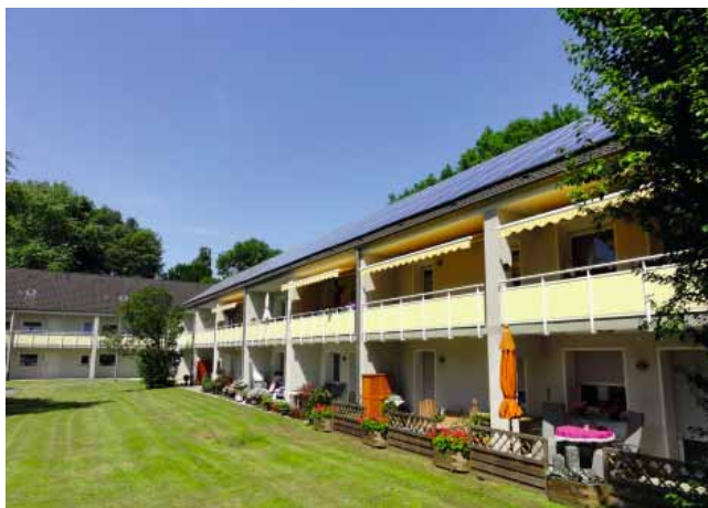
Das im Jahr 1964 errichtete Wohngebäude in Mülheim-Heimaterde wurde in acht Monaten umfangreich saniert. Quelle: AEG Haustechnik
