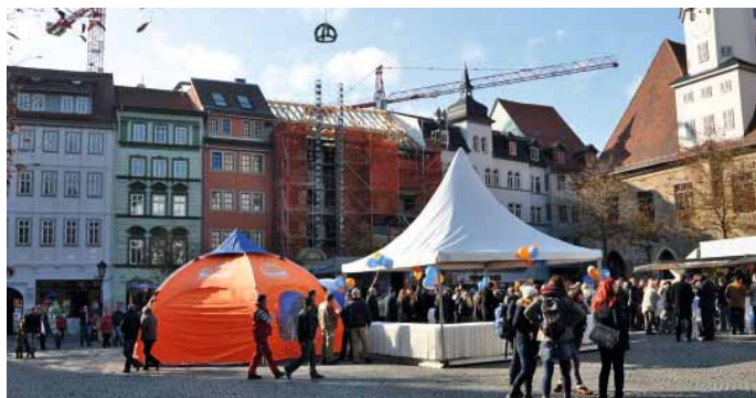
Richtfest: Die Stadt Jena, der Freistaat Thüringen und der Bund unterstützen das Vorhaben durch Fördermittel.
