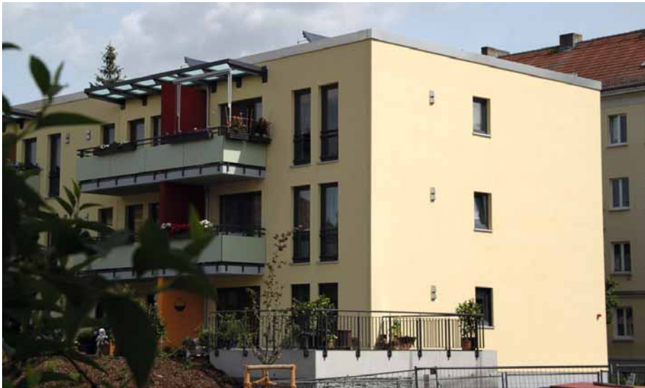
Die Wärmeversorgung des Mehrfamilienhauses erfolgt über Erdwärmepumpe und Solaranlage.
