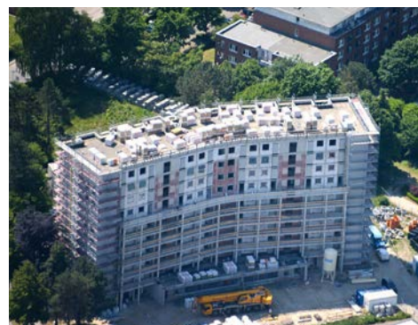
Bei einer Hochhausanierung in Lübeck-Moisling erweiterte die Trave die Wohnungen um die Flächen des alten Laubengangs und setzte vor das Haus eine neue Erschließungsebene
