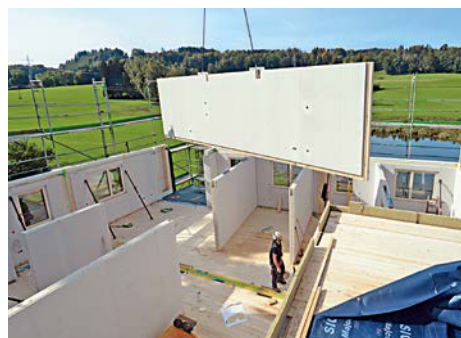
Im Baukastenprinzip wurden die vorgefertigten Holzelemente millimetergenau montiert. In nur sieben Wochen stand die komplette Gebäudehülle
