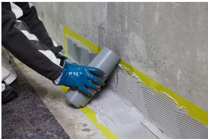
Das ISOTEC-Flexband wird in das Klebebett eingearbeitet.
