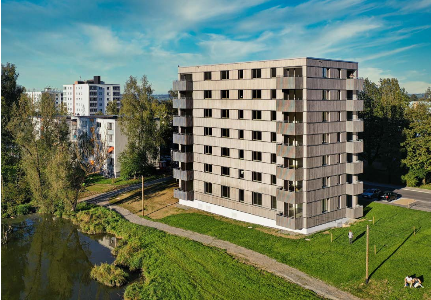
In nur zwölf Monaten Bauzeit hat die Sozialbau GmbH das höchste Vollholzhaus seiner Art in Bayern erstellt. Bei dem 21 m hohen, innovativen Gebäude ist sogar der Aufzugsschacht ganz aus Holz
