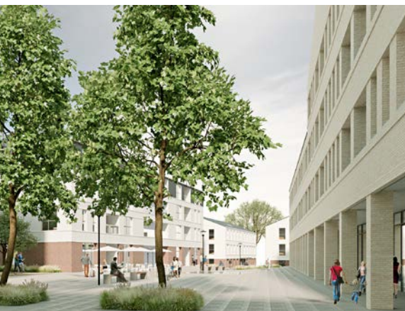
Unweit des Bahnhofs errichtet die Berliner BBG eine neue lebendige Ortsmitte Michendorfs mit Wohnungen und Gewerbeflächen
