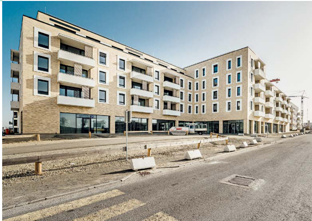
Wie hier am Quartiersplatz werden die Dächer der VWI-Wohngebäude in den Steimker Gärten Anfang 2022 mit PV-Modulen ausgerüstet, um ein Mieterstrommodell anbieten zu können
