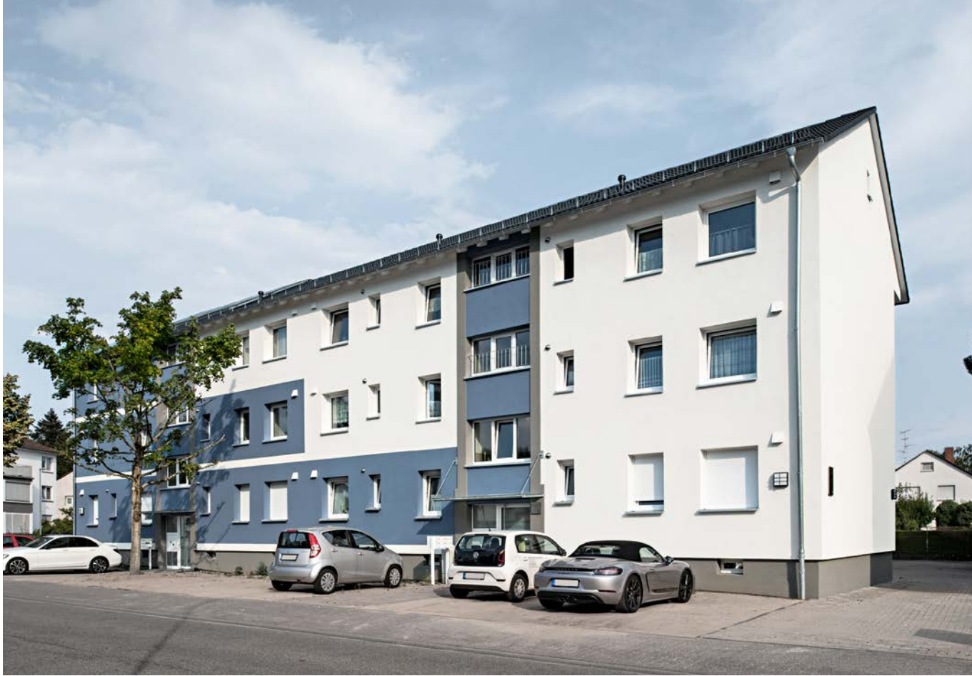
1957 wurden die beiden Gebäudeteile errichtet, die die Baugenossenschaft Langen jetzt umfangreich saniert hat. Nachträglich installiert sind zum Beispiel dezentrale Wohnungslüftungseinheiten mit Wärmerückgewinnung
