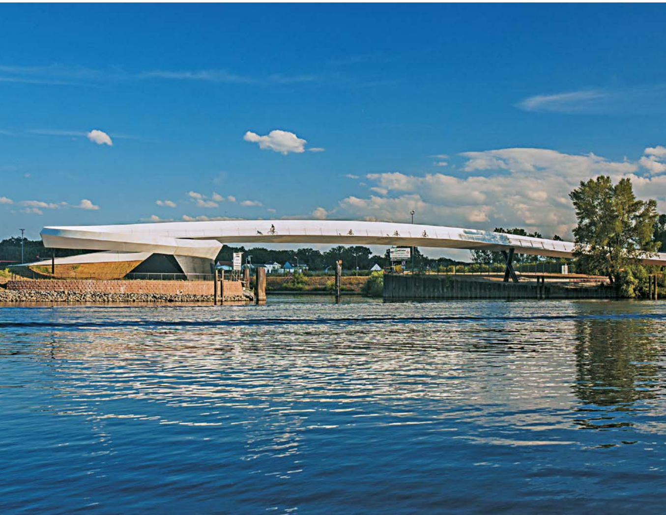
Ölhafenbrücke in Raunheim: Nicht nur besondere Architektur, sondern ein im wahrsten Wortsinn verbindendes Element der „Drei gewinnt“-Kommunen Raunheim, Rüsselsheim und Kelsterbach
