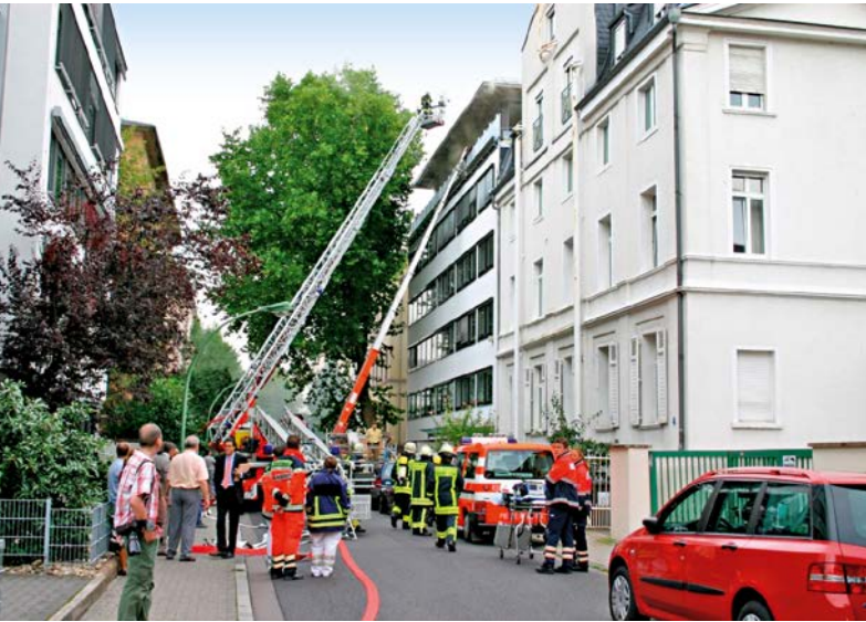
Feuer bei Bauarbeiten einer Geschosserweiterung
