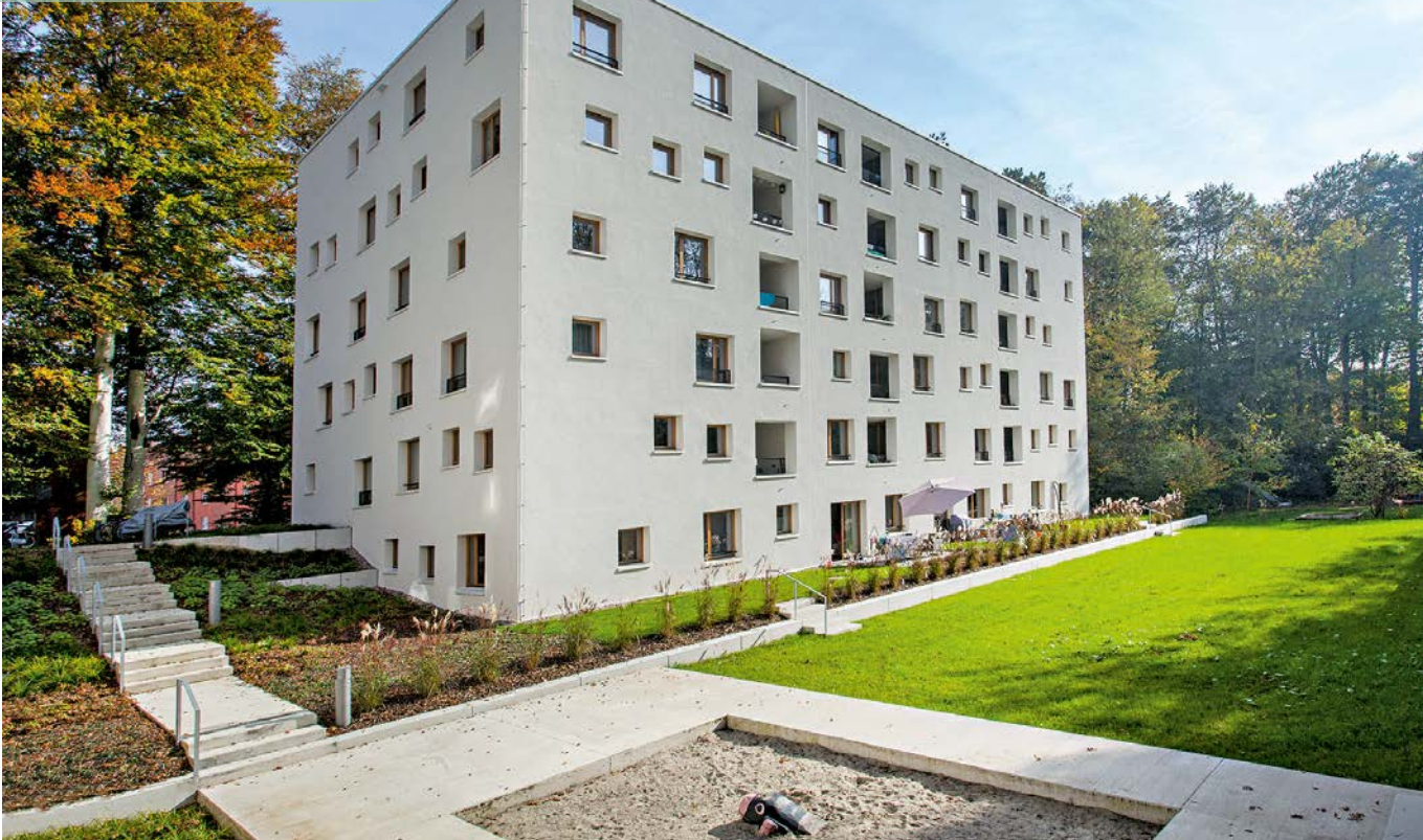
Geförderter Wohnungsbau der Nuwog – ausgezeichnet mit dem „thomaswechspreis“ 2018 und dem Sonderpreis des Deutschen Ziegelpreises 2019. Alle Diwog-Bauprojekte sollen die gleichen Standards erfüllen wie die der Nuwog
