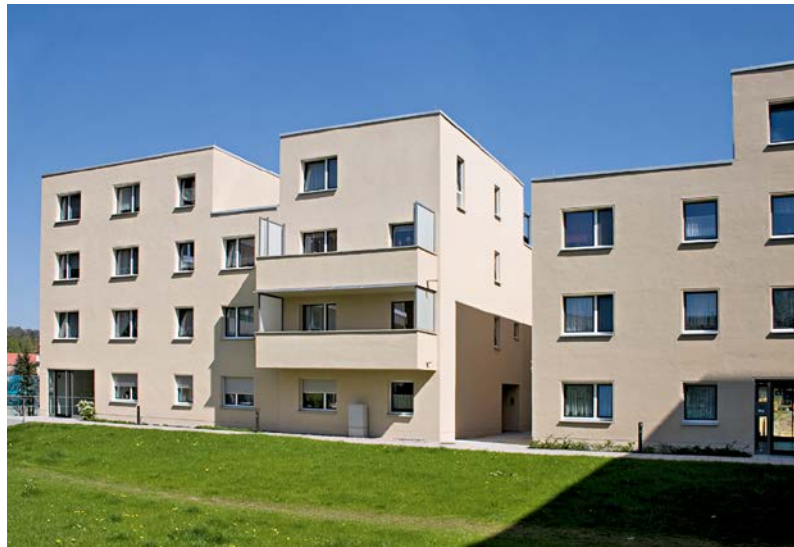
Im thüringischen Sondershausen wurde eine fünfgeschossige Wohnzeile zu einer differenzierten Hausfolge umgebaut
