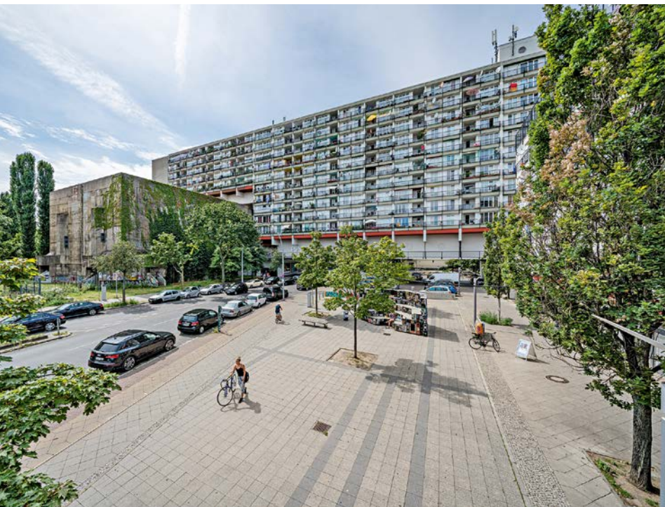
Das Hochhaus überspannt die Pallasstraße und schafft so eine Verbindung zum Hochbunker, der im Zweiten Weltkrieg gebaut wurde und später nicht gesprengt werden konnte
