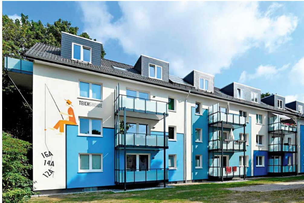
In der Teichsiede in Bielefeld hat die BGW ein Bestandsgebäude aus den 1950er Jahren umfangreich umgebaut und grundlegend saniert. Insgesamt 33 Wohnungen konnten so dem angespannten Wohnungsmarkt zugeführt werden
