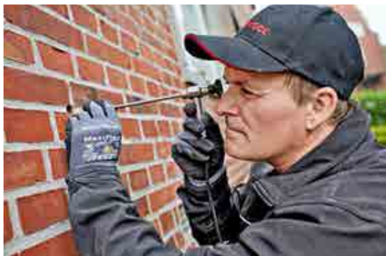
Mit einem Endoskop, das ebenfalls über die Bohrlöcher eingeführt wird, wird der Hohlraum vorab und während der Befüllung kontrolliert
