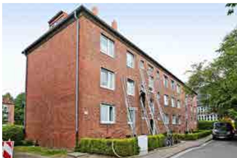
Dank der flexiblen Schlauchverbindungen erreichen die Verarbeiter alle Fassadenbereiche. Die Vorteile für die Bewohner: neue Dämmung in kürzester Zeit ohne Gerüst, Schmutz und nennenswerten Lärm
