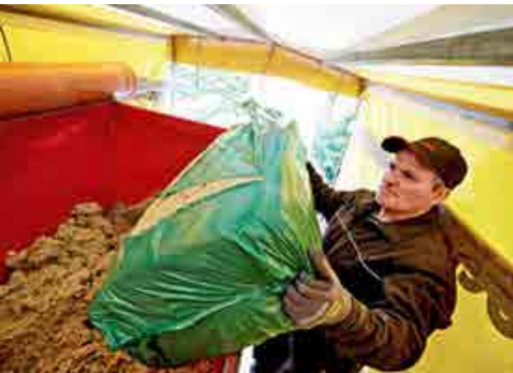
Das Steinwollegranulat wird in die mobile Einblasmachine gegeben, die auf einem Anhänger positioniert ist. Mittels Druckluft wird es später in den Hohlraum zwischen Außenwand und Vormauerwerk geblasen
