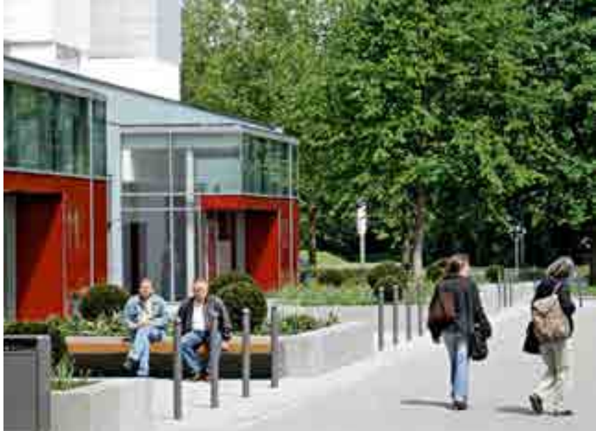
Die Hauseingangsbereiche in Osterholz-Tenever wurden vollkommen umgestaltet. Jetzt gibt es Eingangsgloggien mit Concierge, davor Hochbeete mit Stauden und Bänken als Treffpunkt
