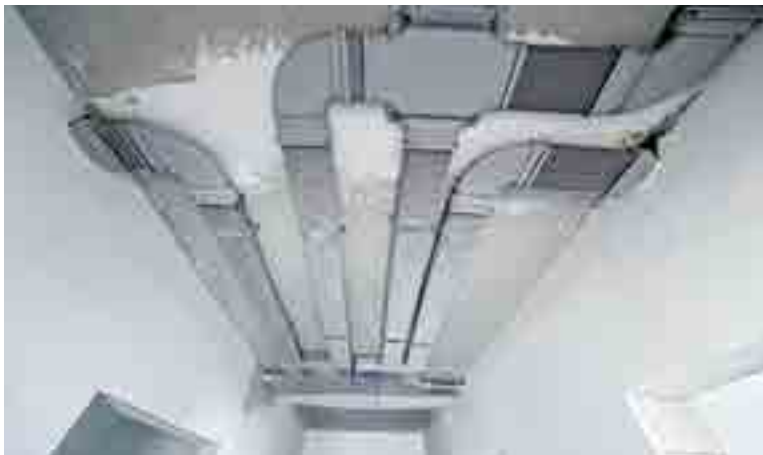
Das flache Luftverteilsystem verschwindet in der abgehängten Decke: Zugluftfrei und ohne Übertragung von Schall aus dem Nebenraum führen sie die verbrauchte Luft ab und bringen frische Luft wieder ein
