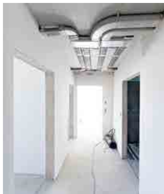
Schallschutz und Hygiene in einem sehr flachen Luftverteilsystem vereint
