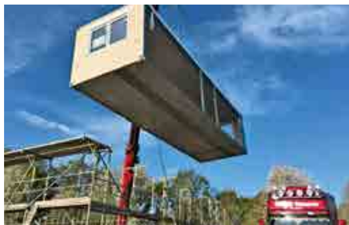
Anlieferung eines Moduls für die Unterakunftsgebäude
