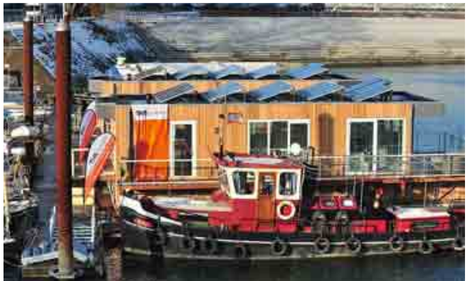
Wasserhäuser im Duisburger Innenhafen
