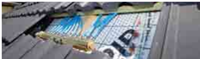
Solardachpfannen werden (fast) wie herkömmliche Dachsteine verborgen. Das Leitungsnetz ist in der Unterkonstruktion verborgen.
