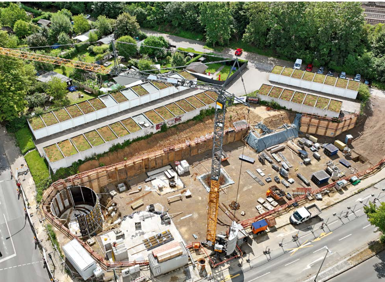
Luftaufnahme der Essen-Nord-Baustelle mit der im Bau befindlichen Zisterne des Eisspeichers (links im Bild)
