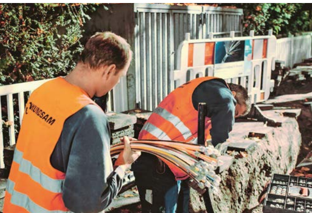
Der Glasfaserausbau nimmt Geschwindigkeit auf. Viele Stadtwerke starteten als Wettbewerber zu etablierten Kabelnetzbetreibern. Mit dem Ausbau der kommunalen Fernwärmenetze kommen ihnen weitere Aufgaben zu
