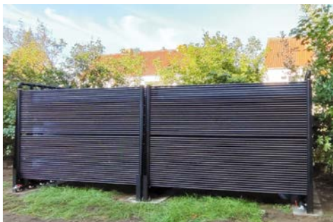
Energiezäune gewinnen Umweltenergie aus der Luft und aus direkter sowie diffuser Sonnenstrahlung. Sie stehen kompakt am Rand des Grundstücks
