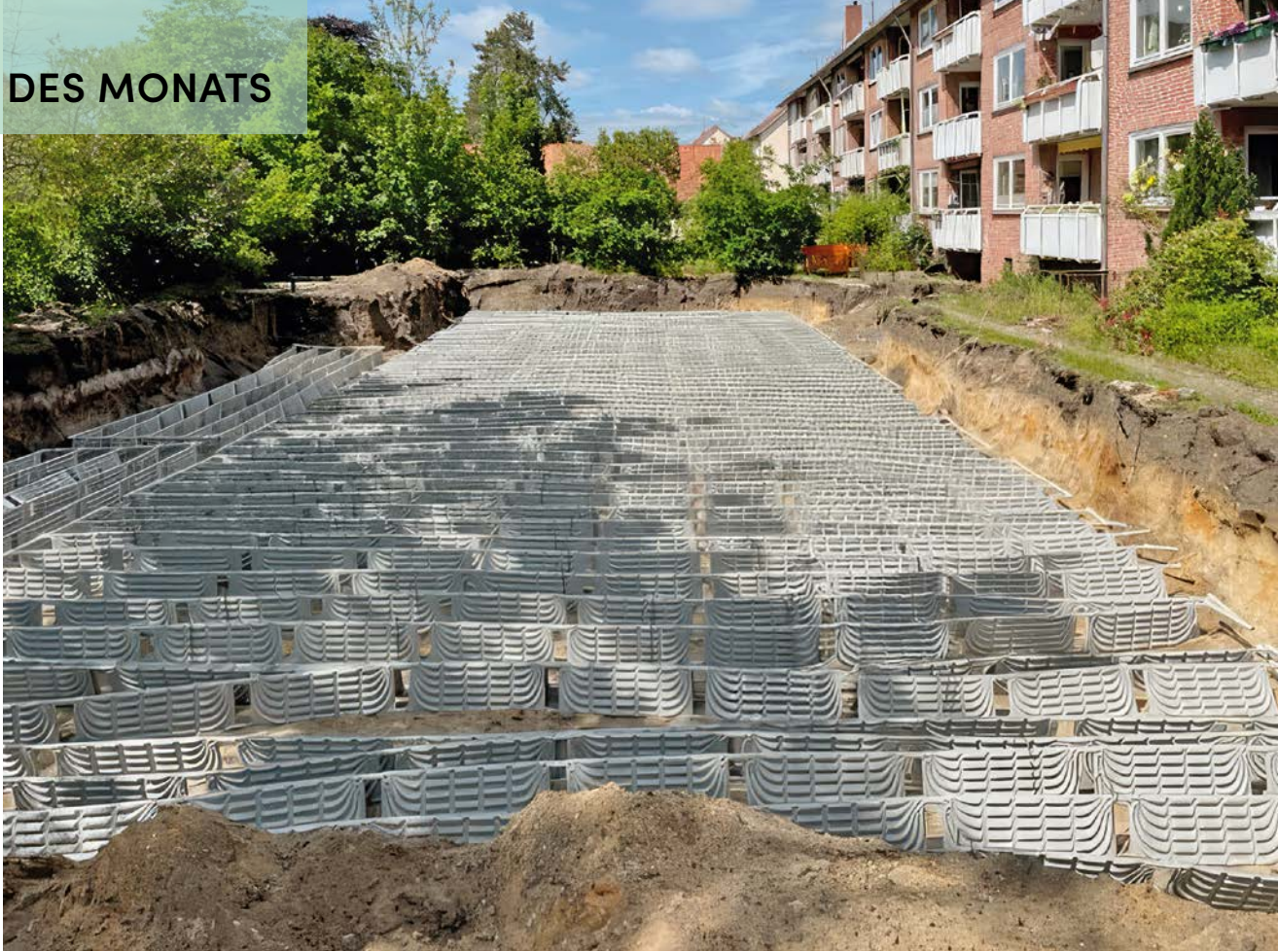
Die Erdwärmekollektoren, hier während des Einbaus, sind auf zwei Ebenen hinter den Gebäuden in einer 1,90 m tiefen Baugrube installiert
