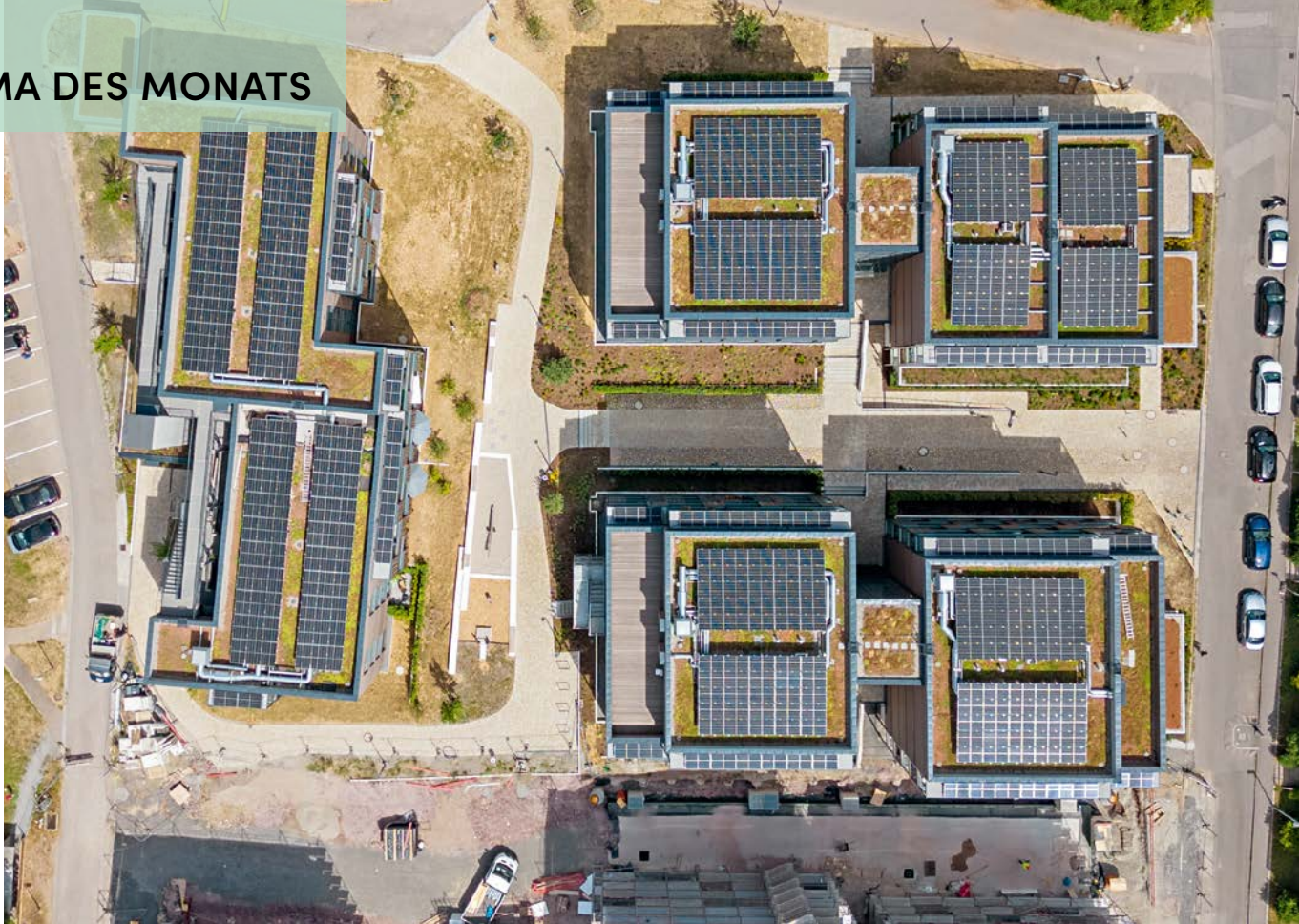
Die Dächer und Fassaden des Neubaus sind mit Solarmodulen ausgestattet
