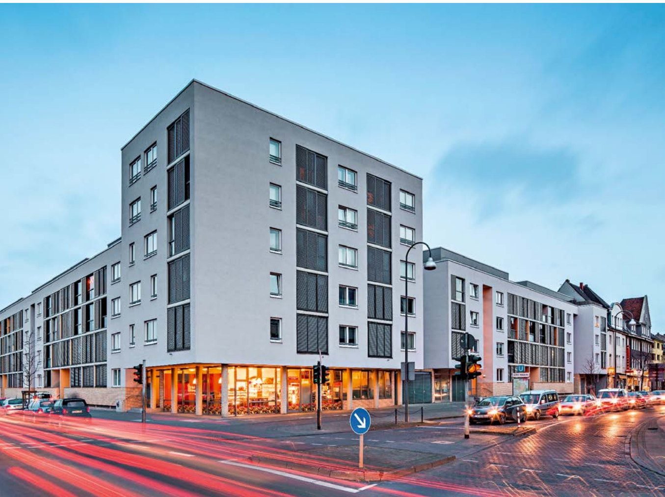
An einer stark frequentierten Kreuzung im Kölner Stadtteil Ehrenfeld hat die Kölner GAG bei einem Neubau 89 Balkone mit schalldämpfenden Glas- und Aluminium-Schiebeelementen ausgestattet
