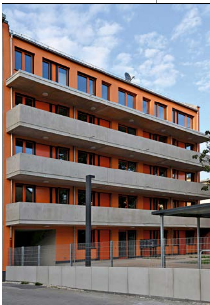
In Nürnberg-Galgenhof hat die WBG 17 Wohnungen für obdachlose Menschen gebaut
