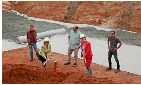
v.l.: N. Hörr (Bauunternehmer), D. Grabe-Bolz (OB Gießen), T. Beaupain (Wohnbau-Bauleiter), D. Haberland (Wohnbau-Geschäftsführerin) und A. Hörr (Bauunternehmer) bei der Grundsteinlegung
