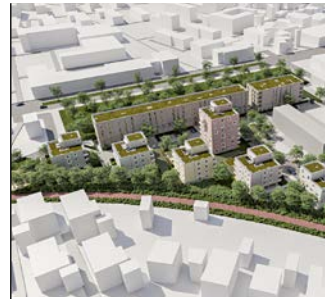
Beim Wohnbauprojekt Westwinkel unterstützen begrünte Dächer das Mikroklima
