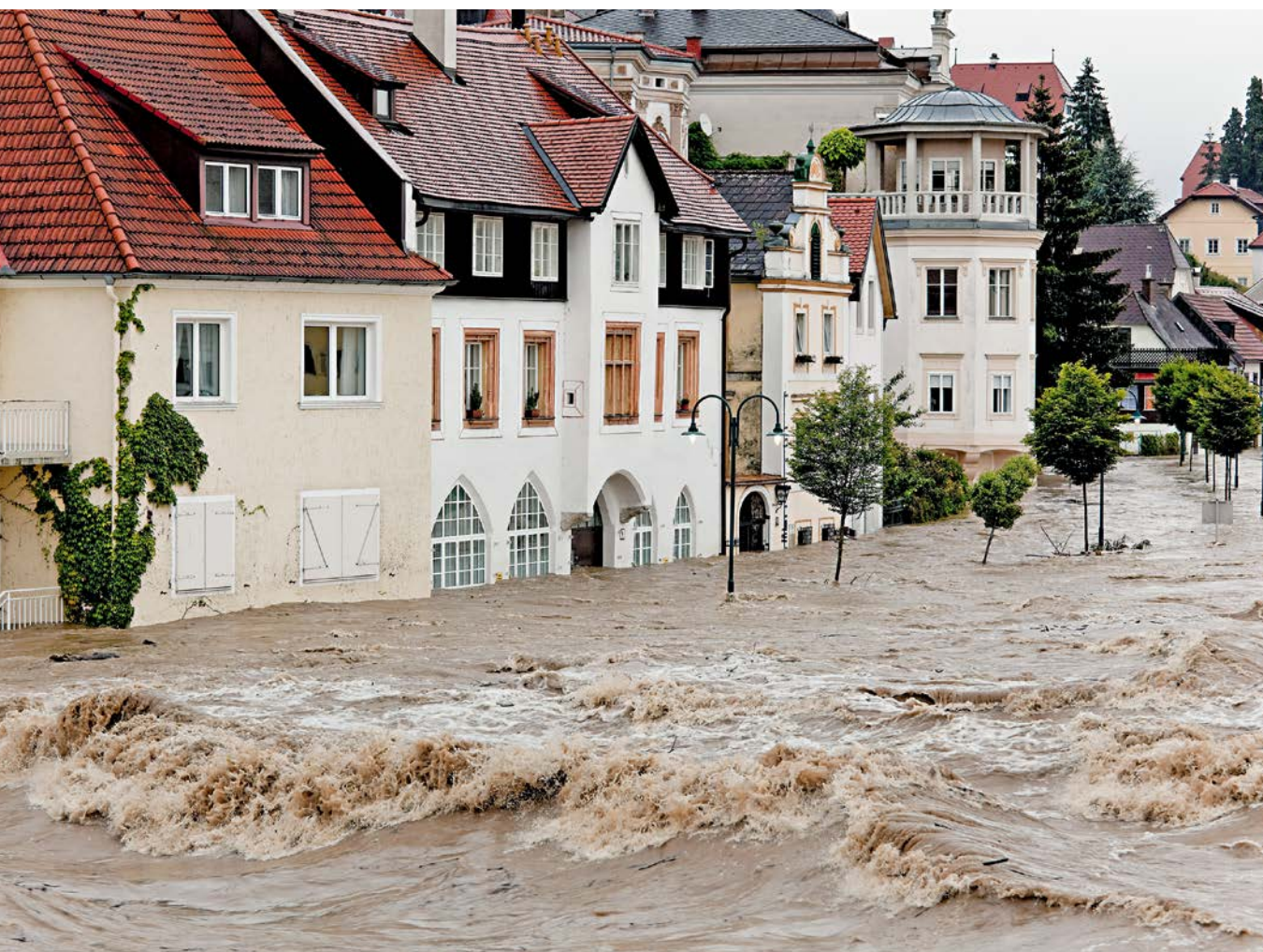
Starkregen und Hochwasser richten mitunter katastrophale Schäden an, insbesondere in Siedlungsgebieten
