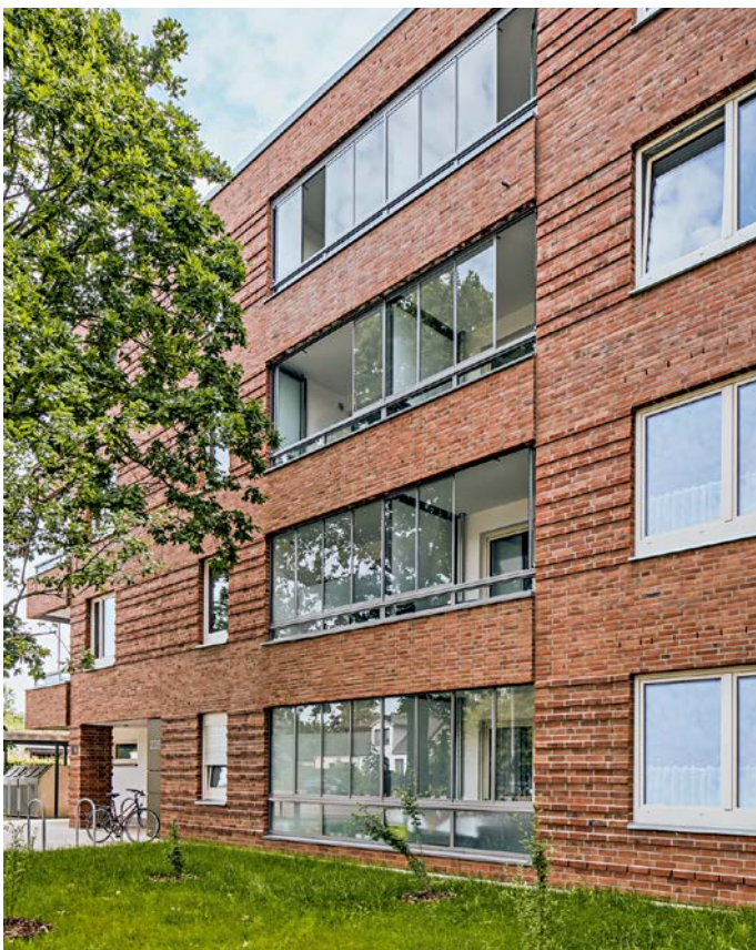
Verglast: Die Loggien beim Neubau „Wohnen am Volkspark“ in Hamburg-Lurup der Baugenossenschaft freier Gewerkschafter eG
