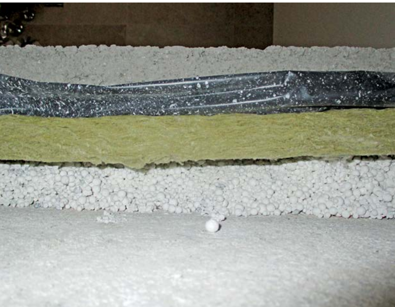
Estrich-Aufbau mit gebundener Schüttung und Faserdämmstoff
