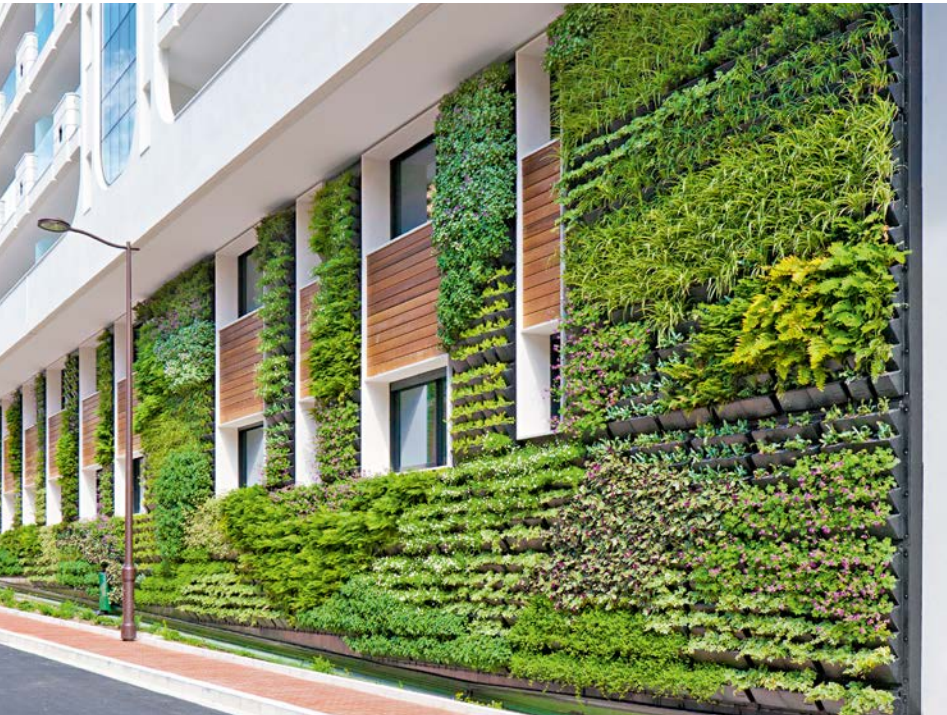
Tun etwas fürs Klima und die Natur: Fassaden- und Dachbegrünungen können außerdem dabei helfen, Gebäude kühl zu halten
