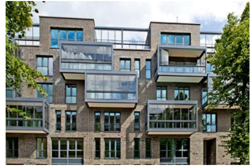
Vielfältige Lösungen bieten die Hersteller für die Verglasung von Balkonen, hier bei einem Mehrfamilienhaus der Hansa Baugenossenschaft in Hamburg
